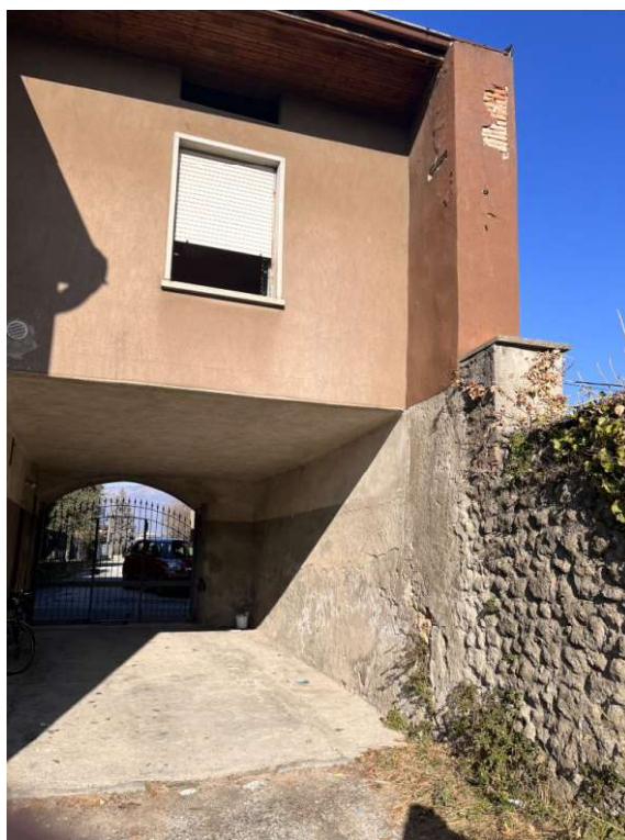
Vista prospetto sud
