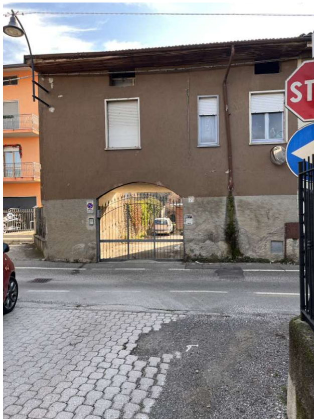
Vista prospetto nord con accesso all'androne comune dalla via Piave
