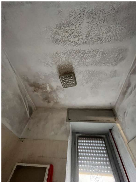
Dettaglio soffitto bagno
