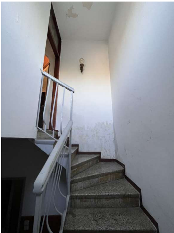
Vano scala ed accesso all'abitazione a p.1°
