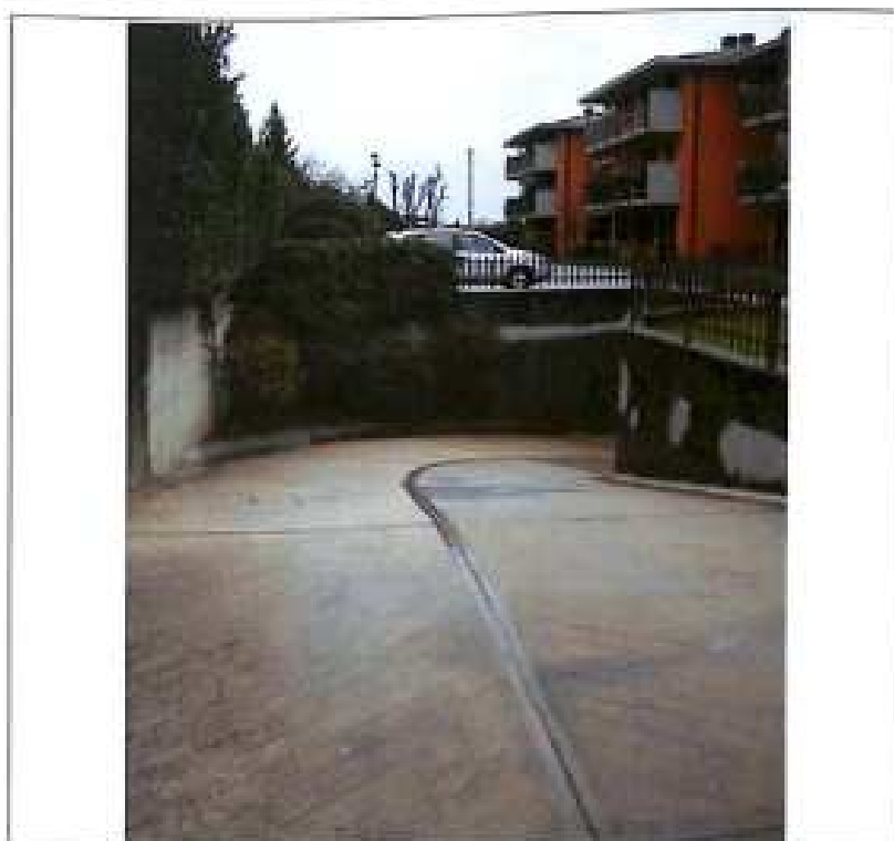
23 - Rampa di accesso autorimessa interrata
