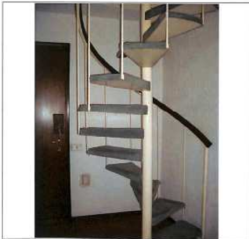
17 - Piano interrato, scala di accesso piano terra
