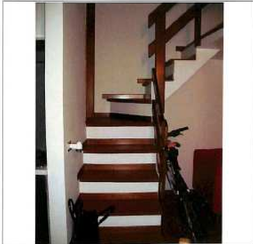
11 - Scala di accesso al servizio igienico e al soppalco
