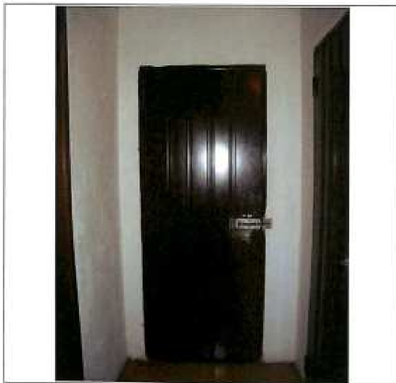
21 - Piano interrato, porta di accesso cantina
