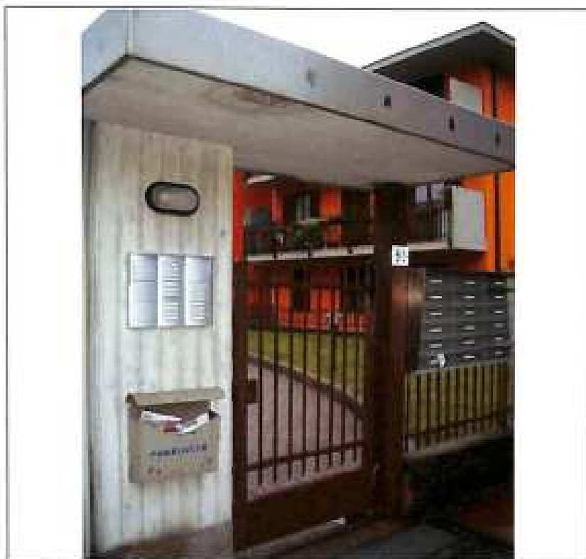
01 - Cancello pedonale area condominiale
