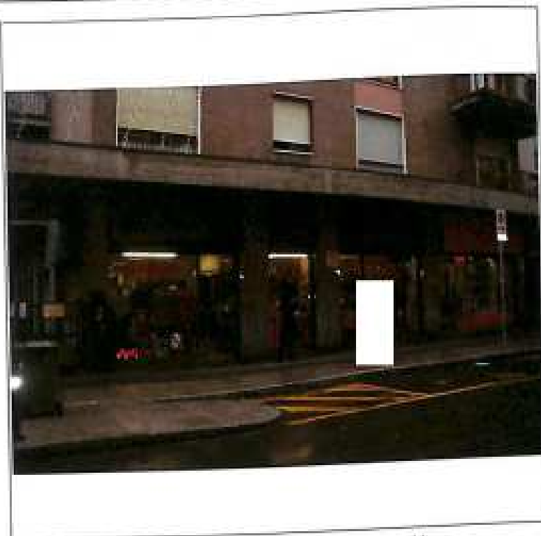
01 - Sud-Ovest, prospetto via Quarenghi
