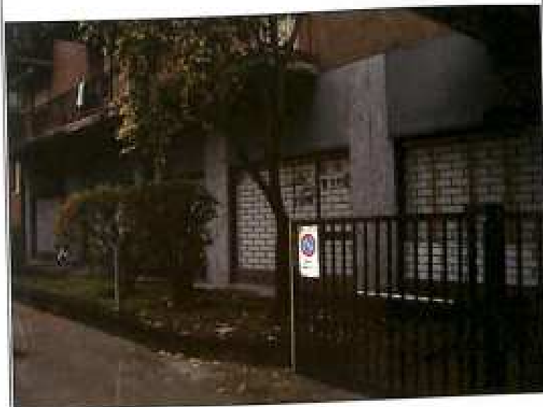
03 - Nord-Ovest, prospetto cortile interno
