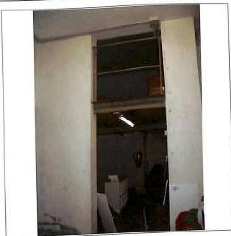
09 - Piano interrato, magazzino
