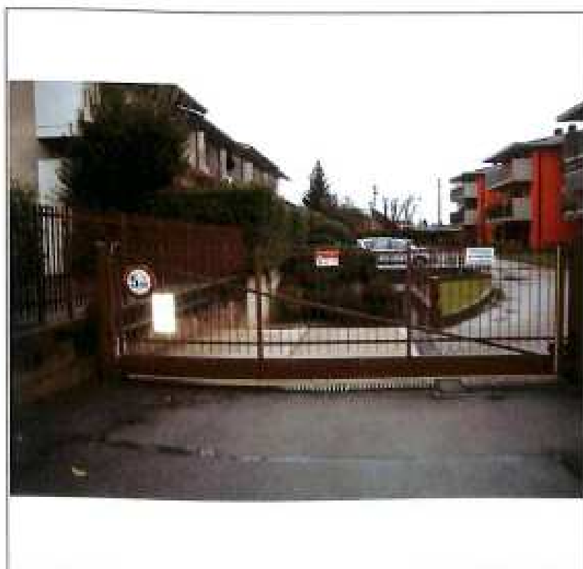
02 - Cancello carrabile area condominiale
