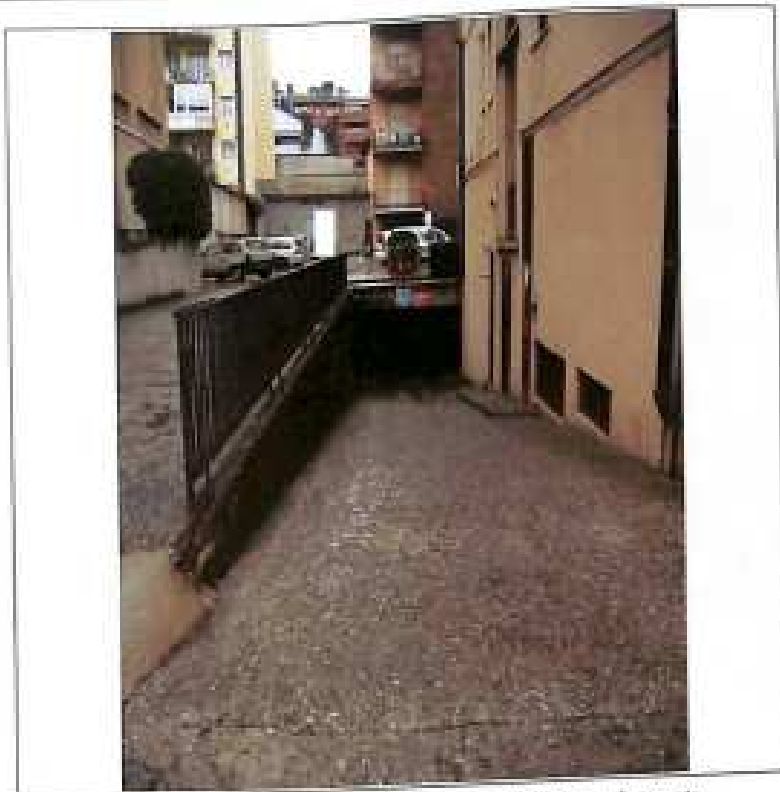
13 - Cortile esterno, rampa di accesso autorimessa interrata
