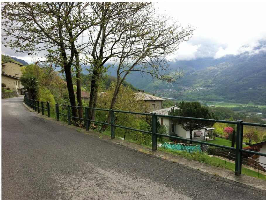
Vista limite terreno/strada comunale - corrimano a destra
