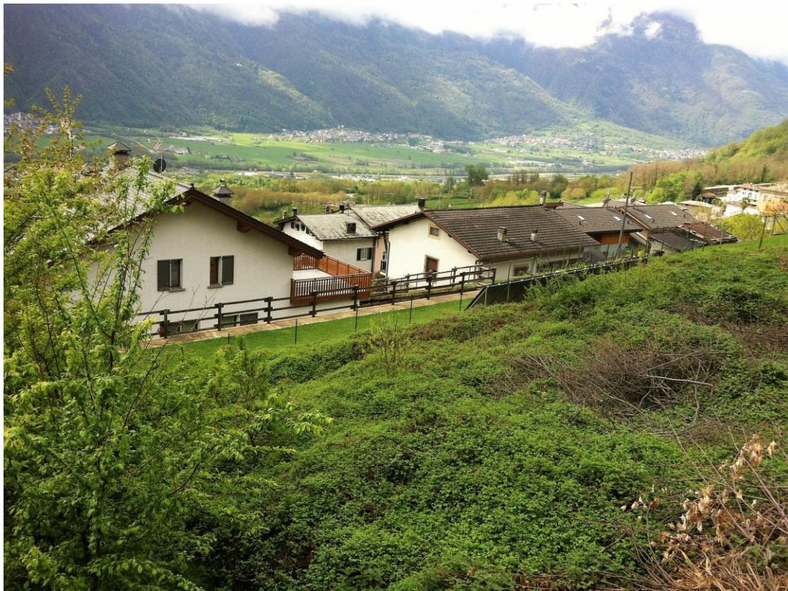
Vista sul fondovalle e case vicine
