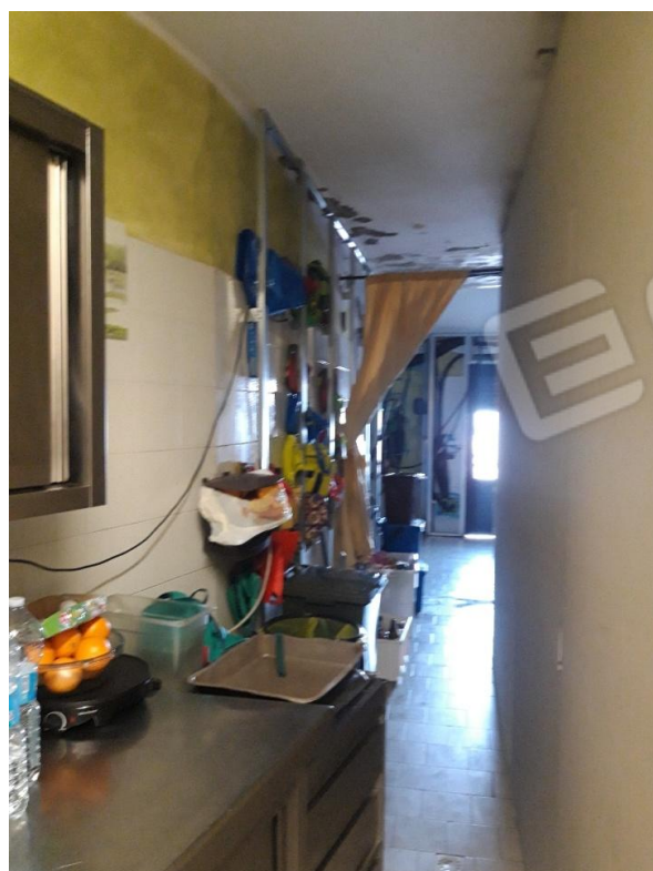
Vano 2 in fase di ristrutturazione
