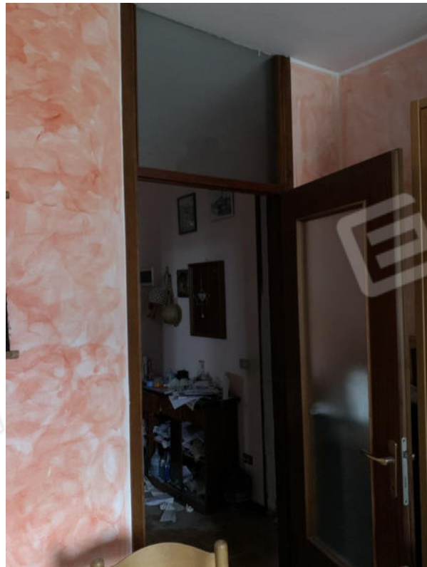
Serramenti interni porta con sopra luce
