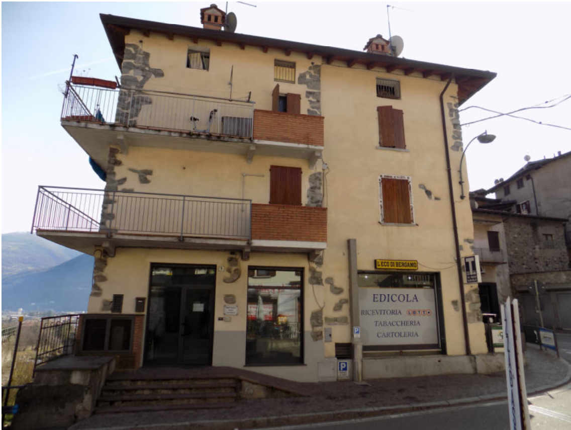
vista fronte Ovest
