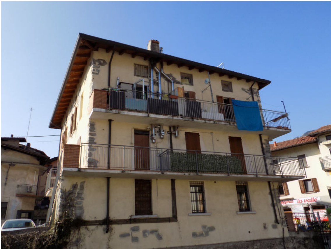
fronte Nord-Est su alveo torrente
