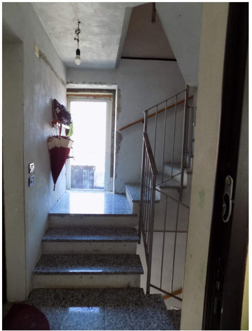
accesso balcone esterno da vano scala comune (di fronte ingresso appartamento)
