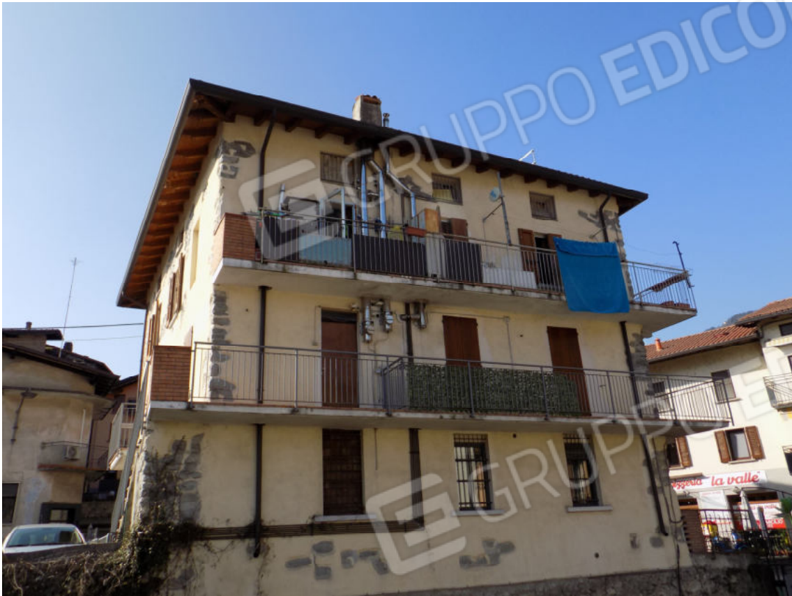
fronte Nord-Est su alveo torrente
