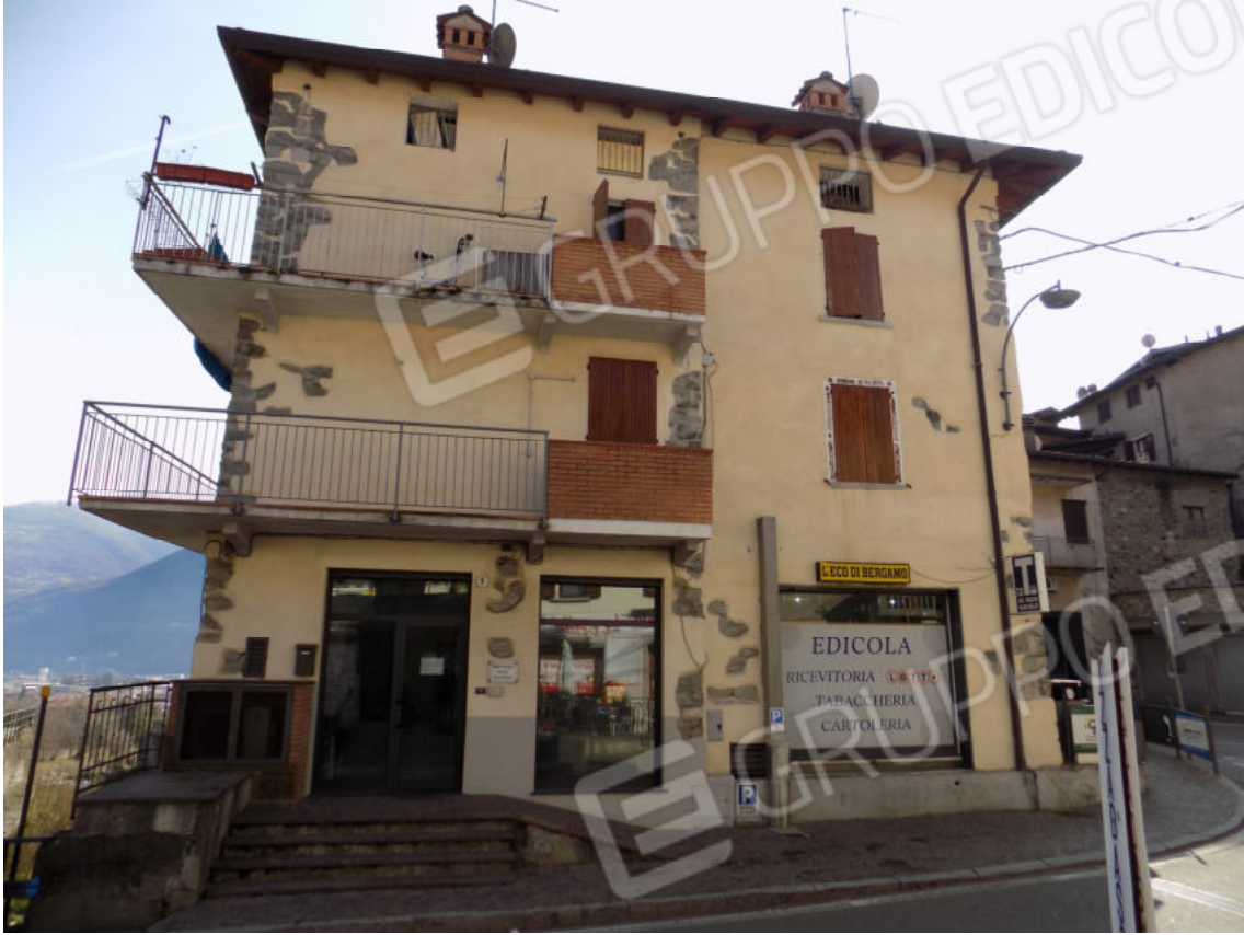
vista fronte Ovest
