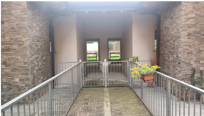
accesso da area comune
