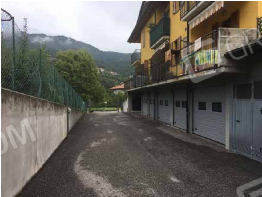
Vista ingresso carrale da ovest
