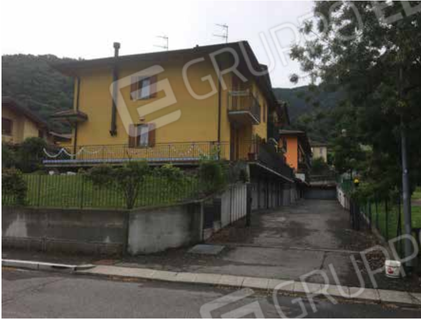
Vista ingresso carrale da ovest
