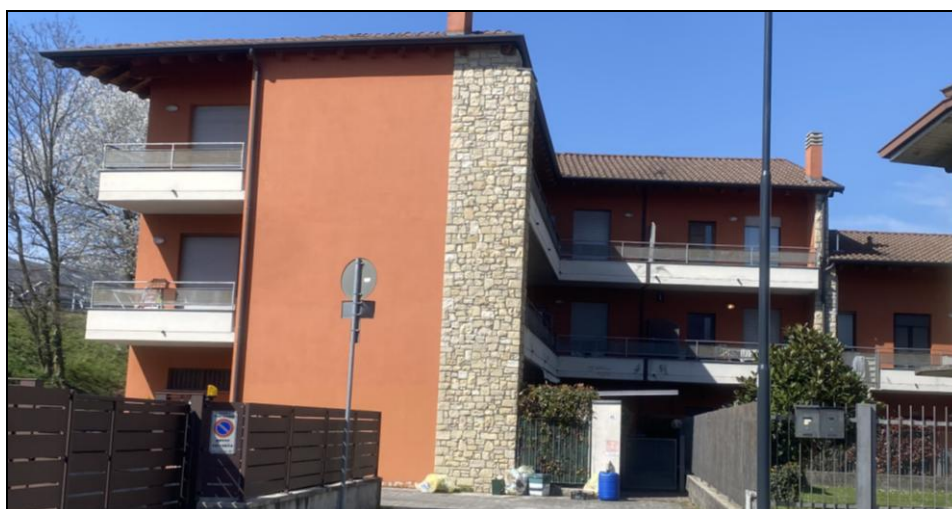
Facciata sud con ingresso del complesso immobiliare
