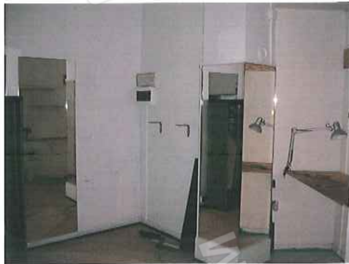
Foto 4 – dettaglio locale interno negozio sub. 3
