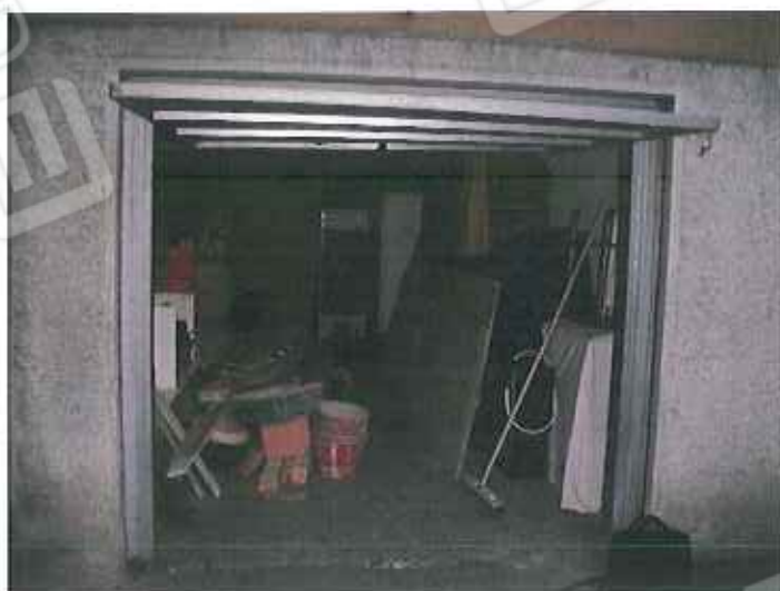
Foto 7 – dettaglio locale magazzino sub. 34
