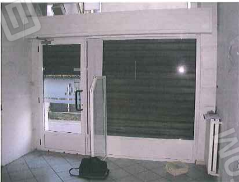
Foto 3 – dettaglio vetrina ingresso locale negozio sub. 4
