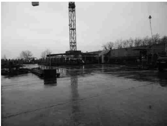
F. 6 mapp. 2212 sub. 702 Resta il muro su cui si sarebbe dovuta edificare la tettoia
