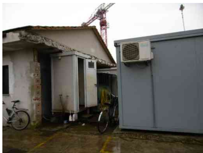
F. 6 mapp. 2212 sub. 705 (come si vede è stato demolito)
