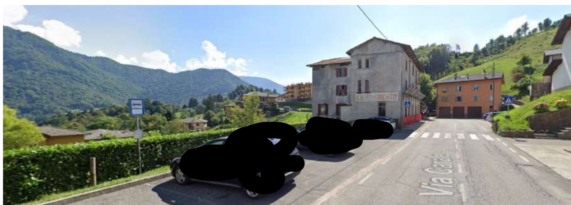
Foto n. 2 | Vista generale dell'edificio e del suo contesto.
