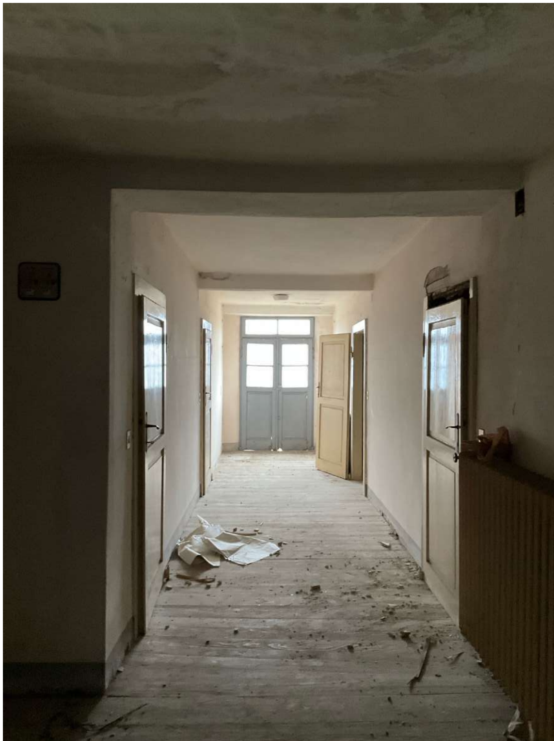
Foto n. 30 | Secondo Piano: il corridoio che disimpegna le camere d'albergo.
