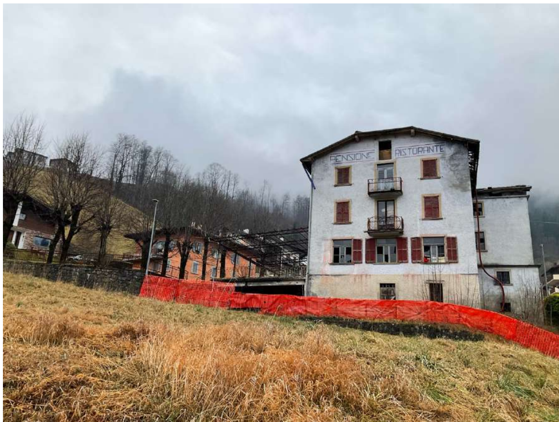
Foto n. 7 | Vista della facciata Est dell'edificio.
