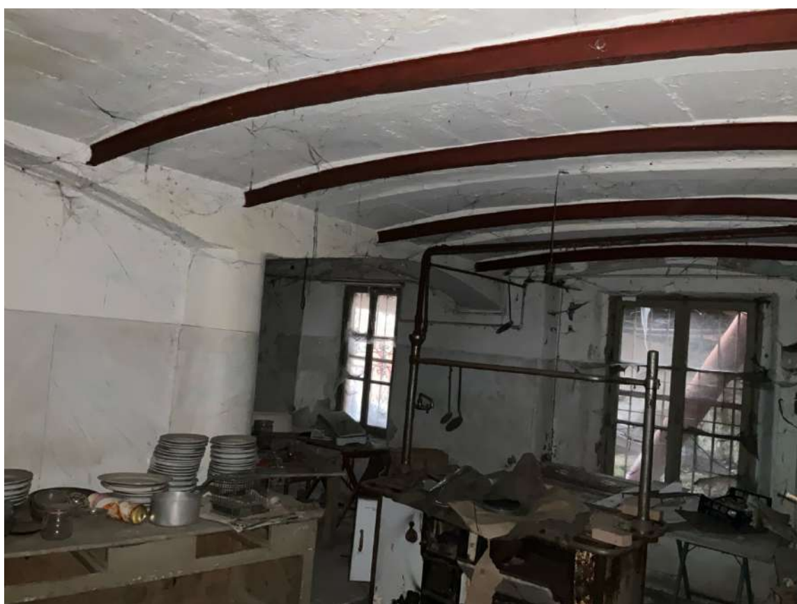
Foto n. 40 | Piano Seminterrato: vista dell'ambiente destinato a cucina.
