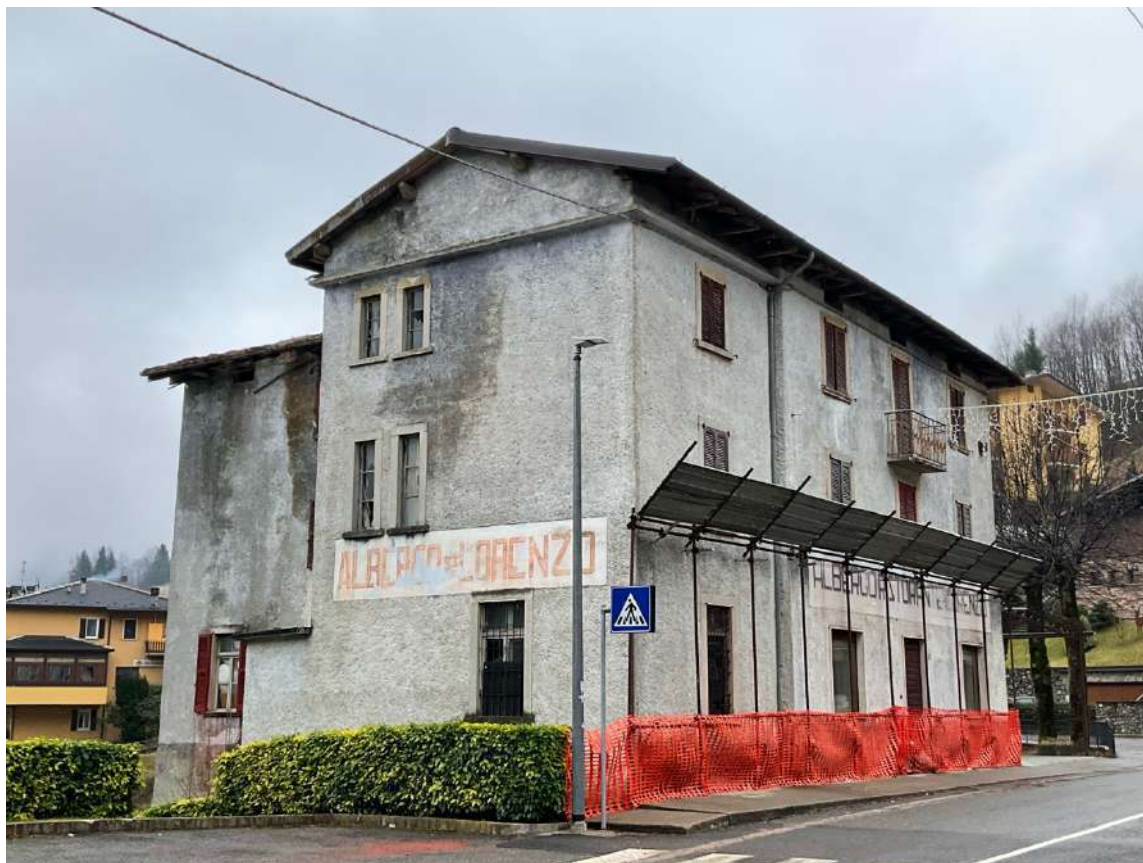
Foto n. 3 | Vista generale dell'edificio su via Carale.
