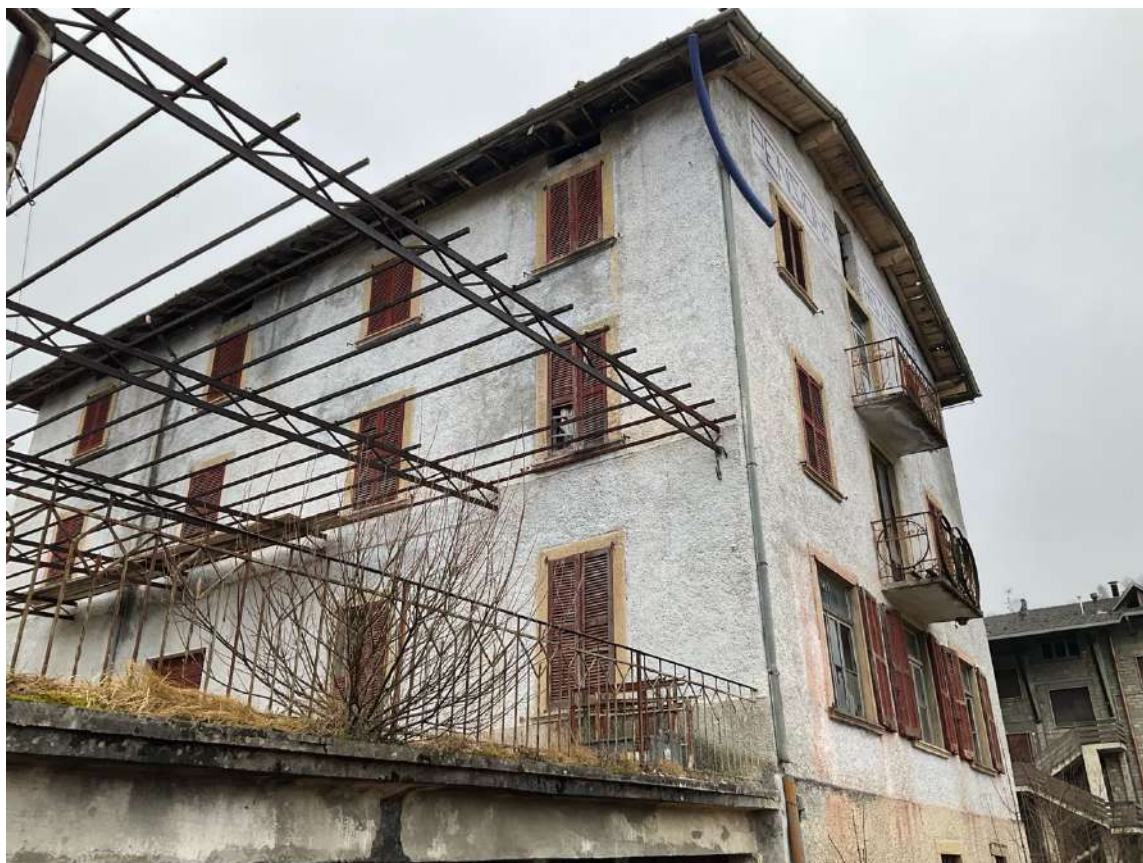
Foto n. 8 | Vista delle facciate Est e Sud dell'edificio.
