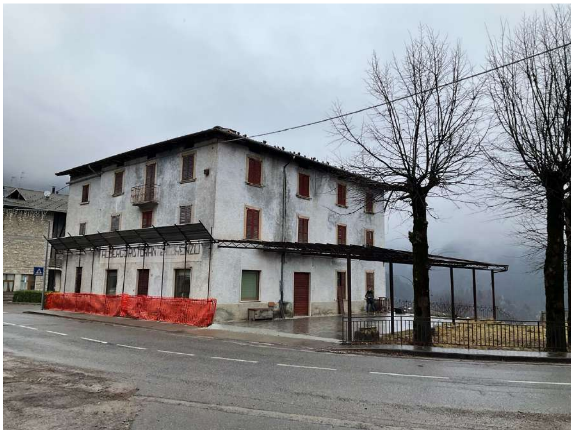
Foto n. 5 | Vista generale dell'edificio con la terrazza e la struttura del vecchio pergolato.
