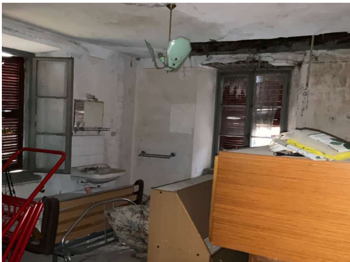
Foto n. 25 | Vista di una camera d'albergo.
