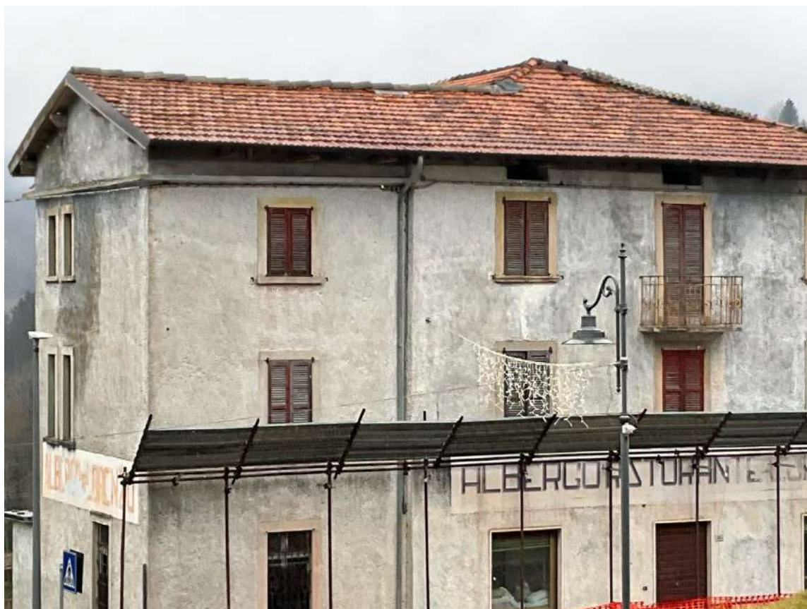
Foto n. 4 | Vista dell'edificio verso via Carale e della sua copertura.
