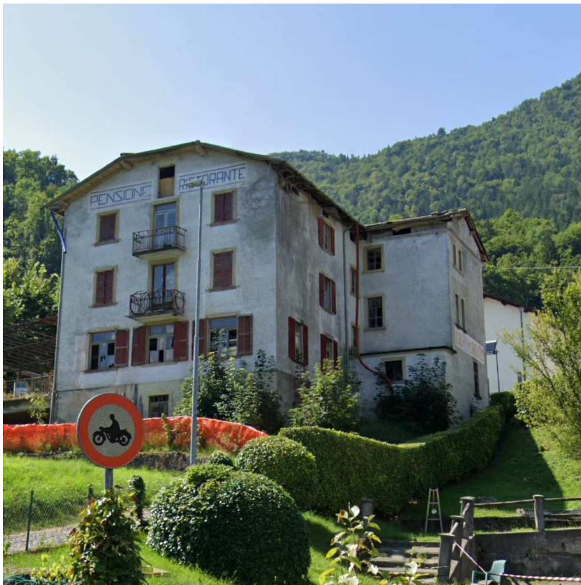
Foto n. 9 | Vista della facciata Nord ed Est dell'edificio.
