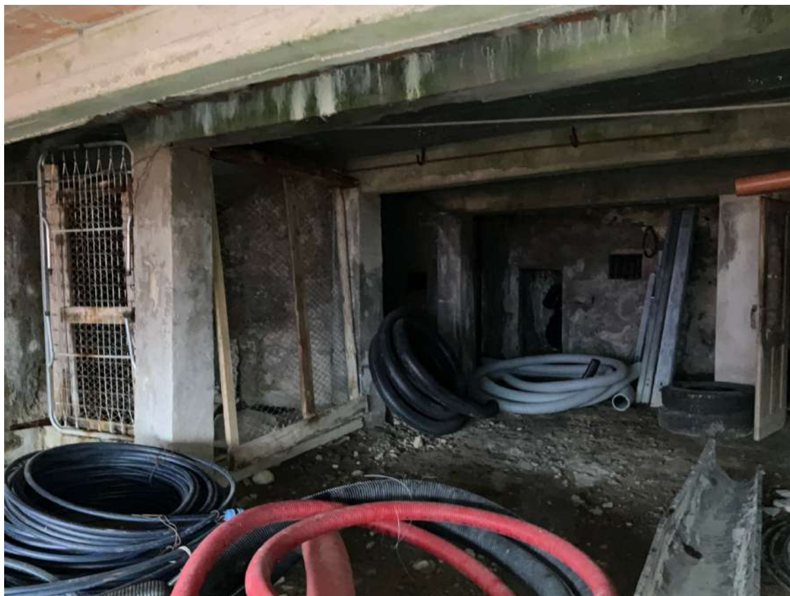
Foto n. 13 | Vista della parete a sinistra e di fondo del porticato.
