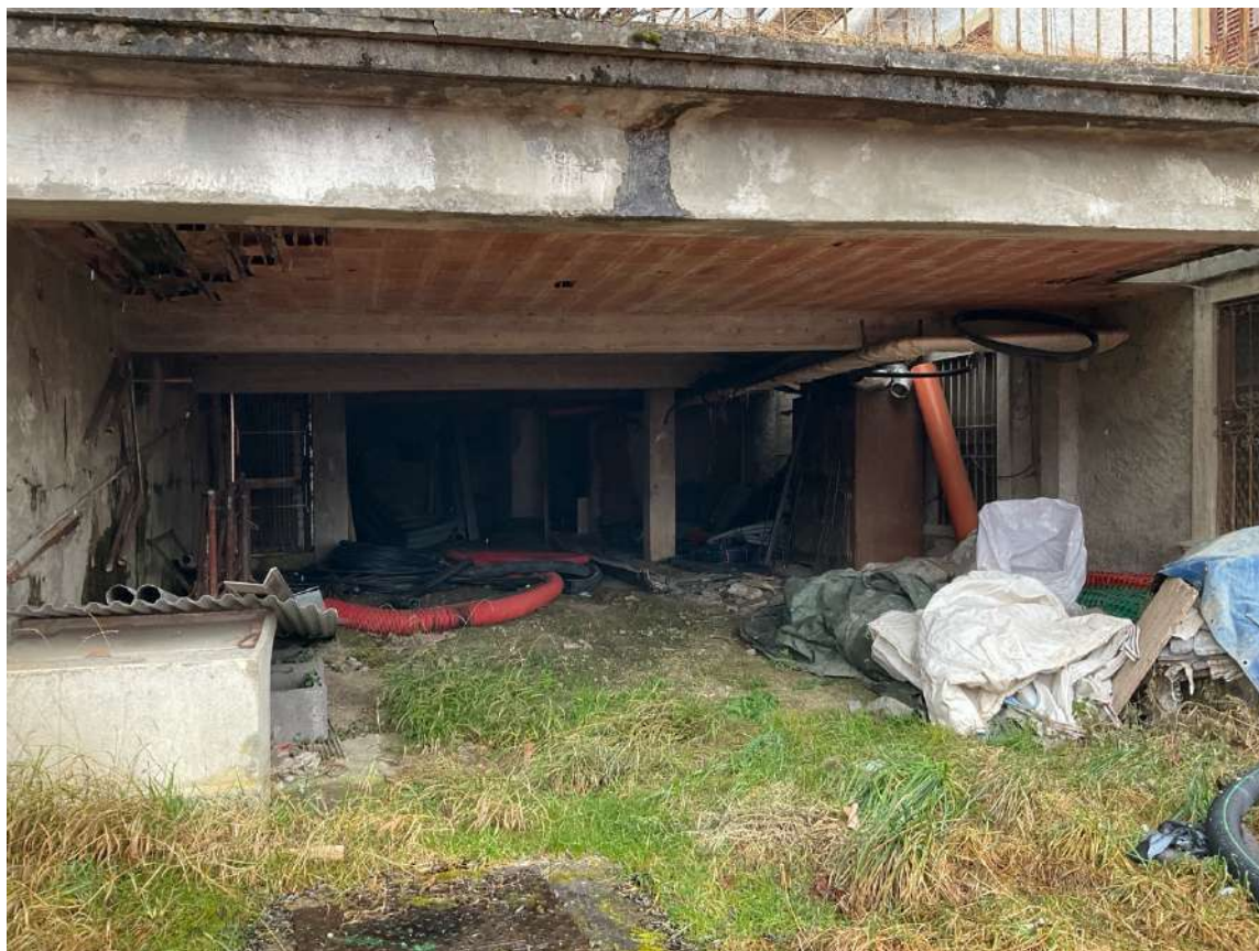
Foto n. 11 | Vista del porticato sotto la terrazza.
