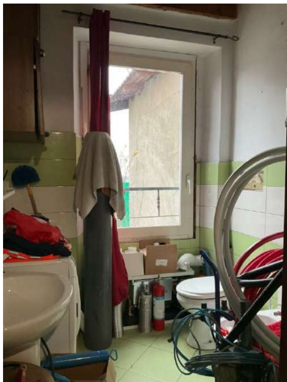
Foto n. 19 | Vista del bagno del monolocale al Primo Piano.
