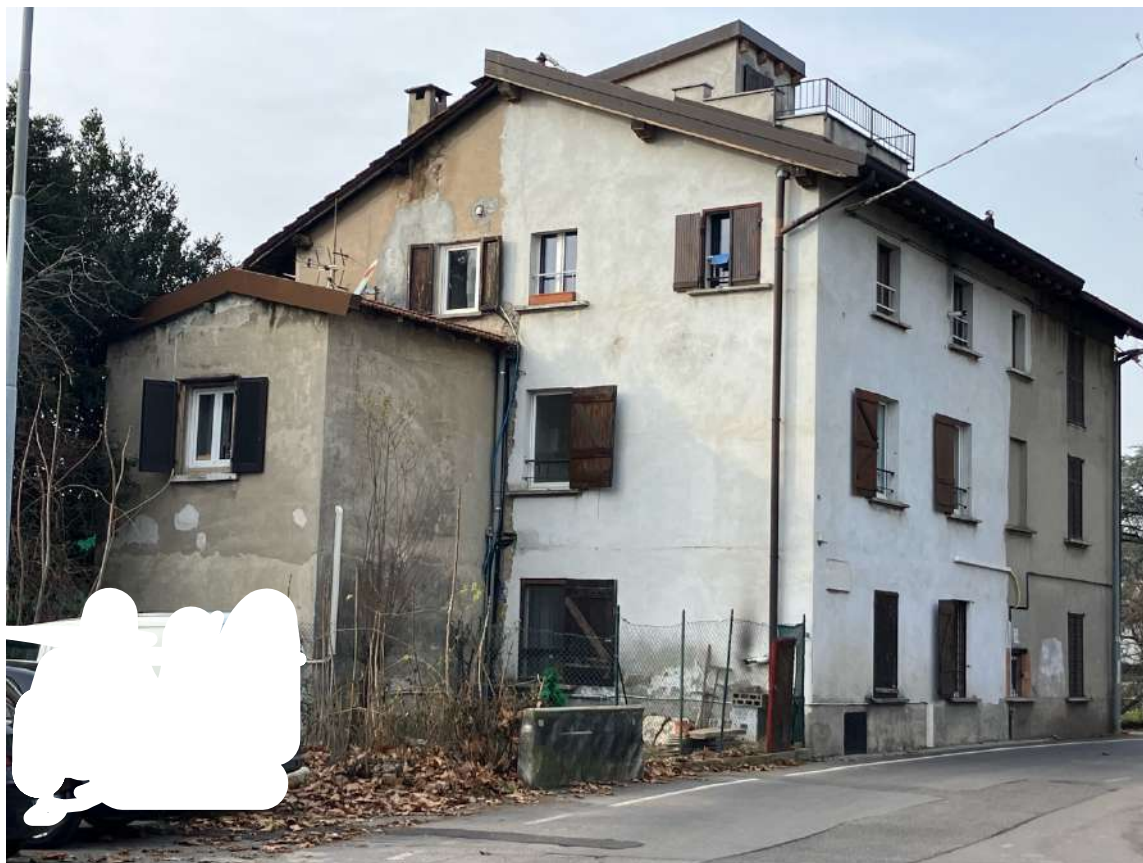
Foto n. 5 | Vista generale dell'edificio con il volume del sottotetto.
