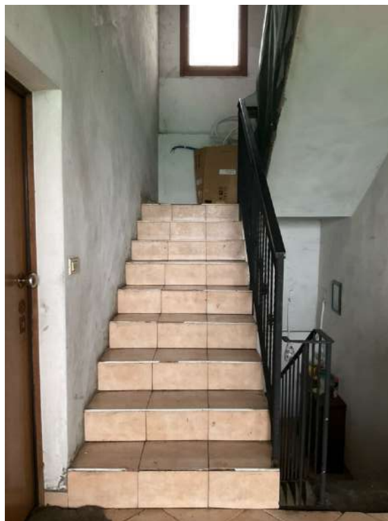
Foto n. 20 | Vista della scala comune che conduce al Secondo Piano.
