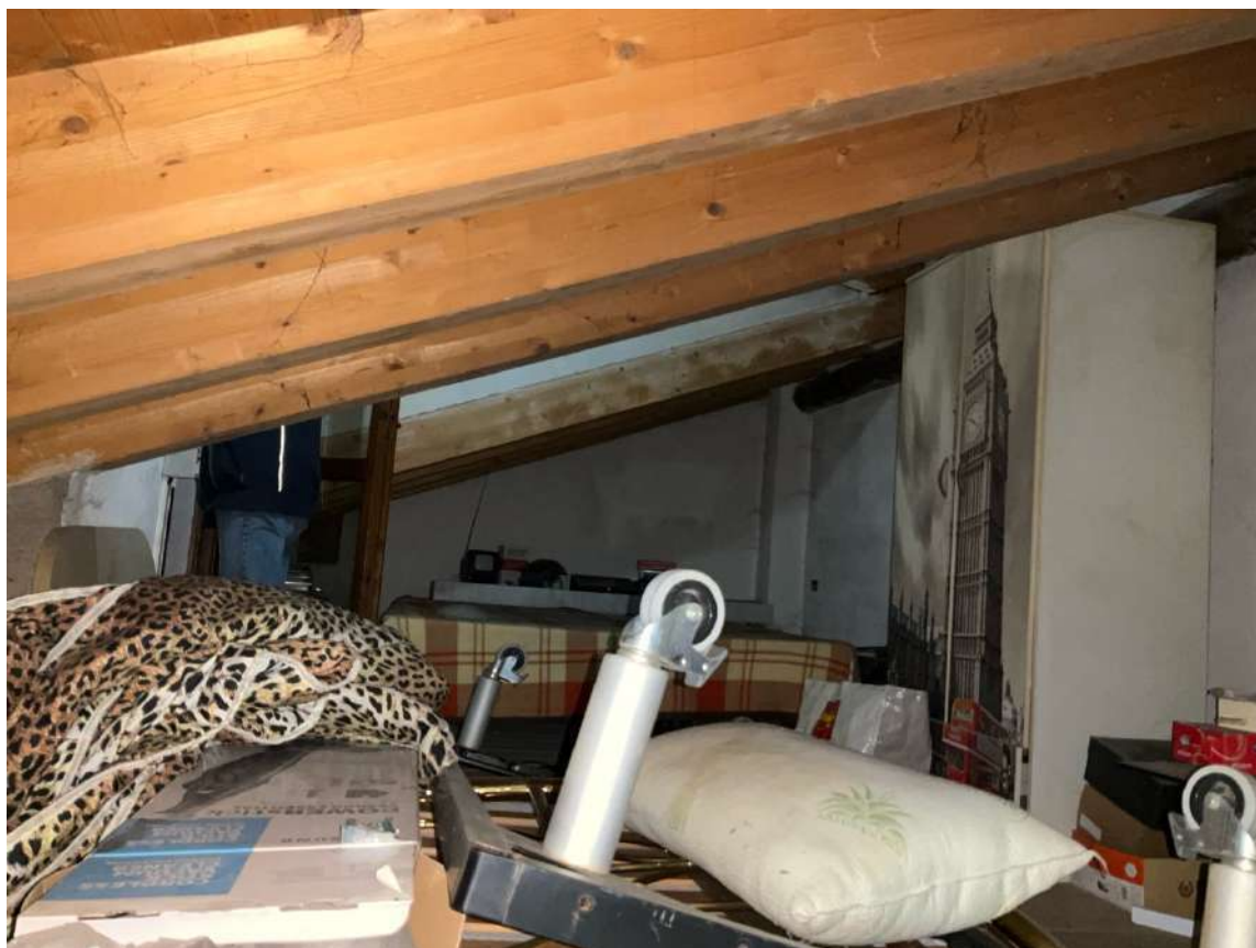
Foto n. 27 | Vista del soppalco del monocale al Secondo Piano.
