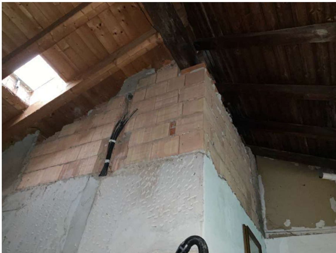
Foto n. 22 | Vista della copertura.
