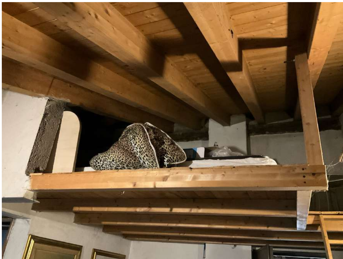
Foto n. 26 | Vista del soppalco del monocale al Secondo Piano.
