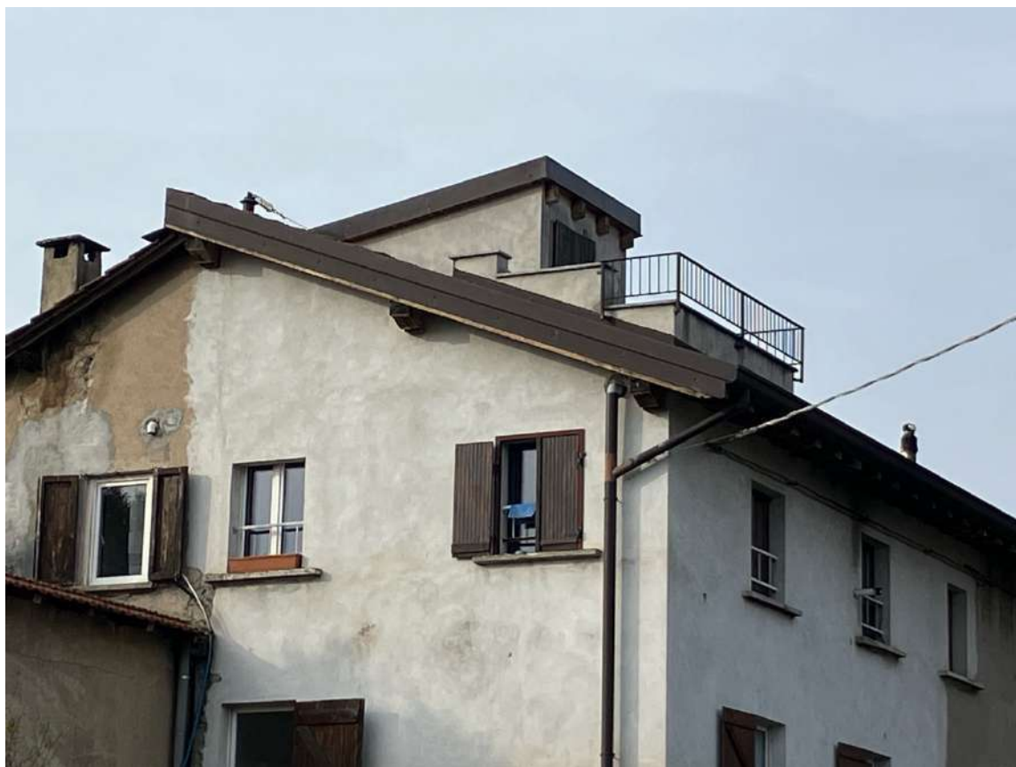
Foto n. 6 | Vista del volume con balconcino nel sottotetto.
