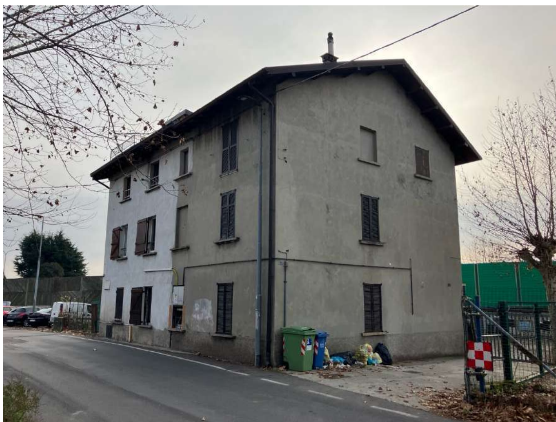
Foto n. 2 | Vista generale dell'edificio con, sulla destra, l'ingresso al cortile.
