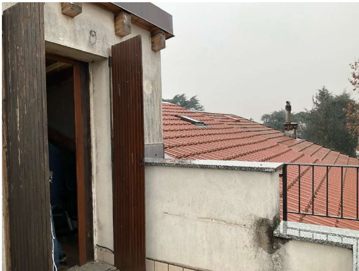
Foto n. 28 | Vista del balconcino del monolocale al Secondo Piano.
