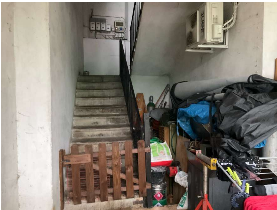
Foto n. 13 | Vista della scala comune per l'accesso al Primo Piano.
