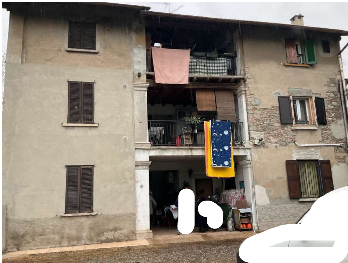
Foto n. 7 | Vista dell'edificio verso il cortile comune.
