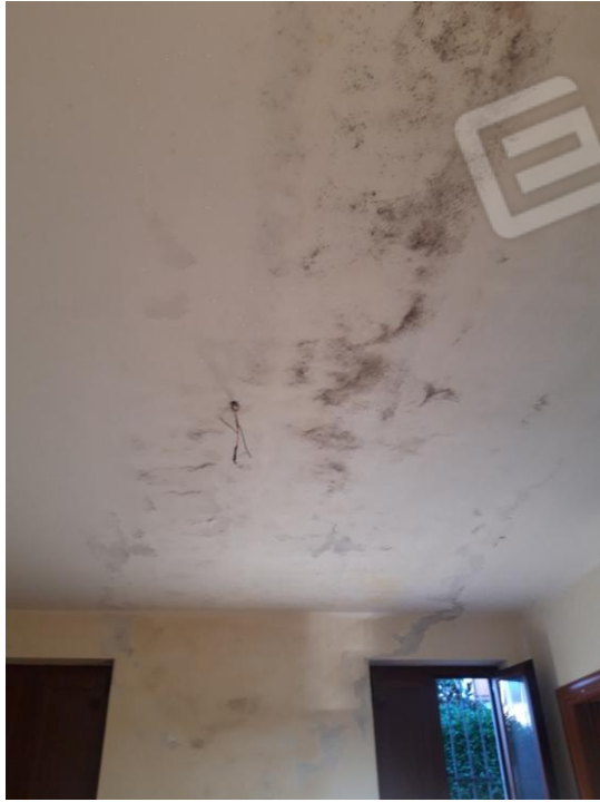
Vista 2 soffitto soggiorno
