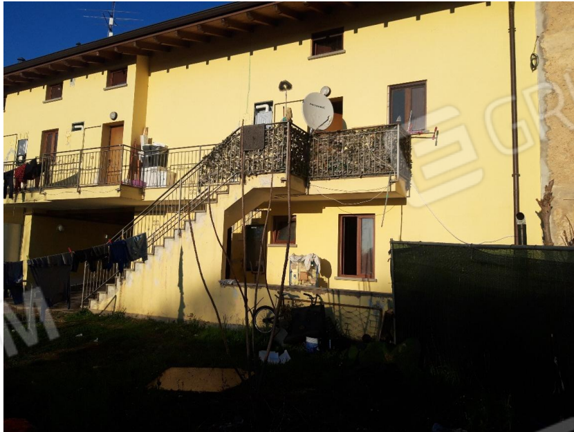
vista esterna - ripresa da sud
