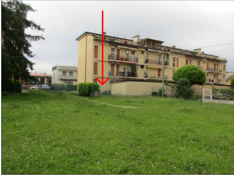
Vista da area verde comune ai fabbricati INACASA
