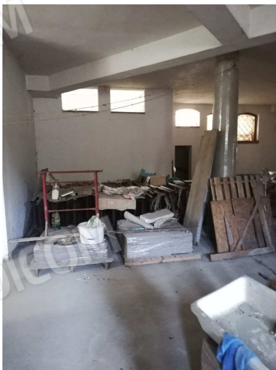
VISTA 31 – interrato appartamento
