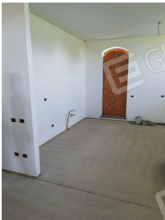
VISTA 49 – appartamento piano 1°
