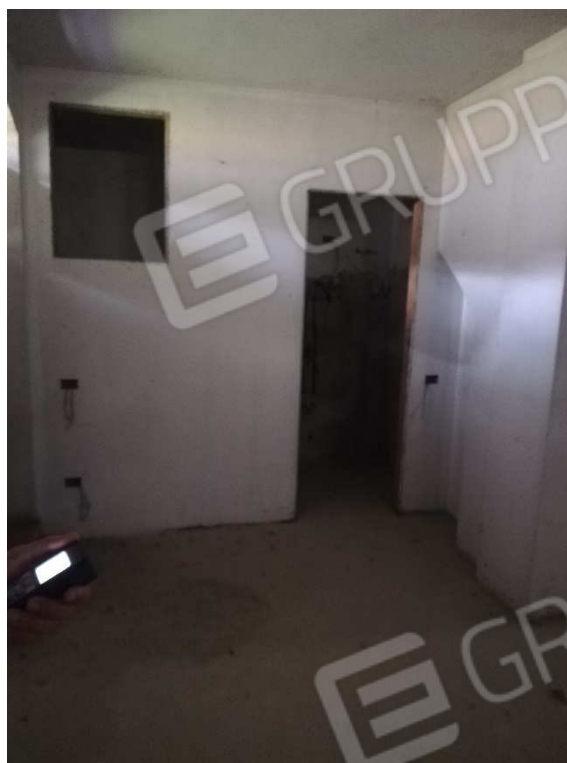
VISTA 15 – interrato uffici
