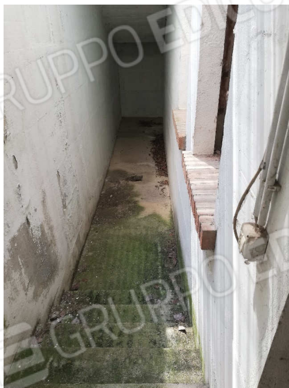
VISTA 17 – interrato uffici
