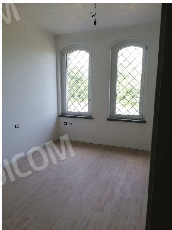
VISTA 41 – appartamento piano T
