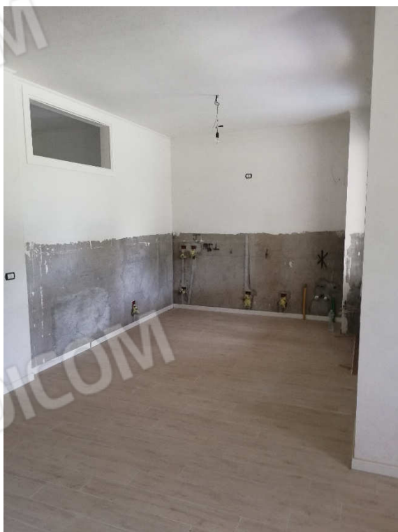
VISTA 37 – appartamento piano T
