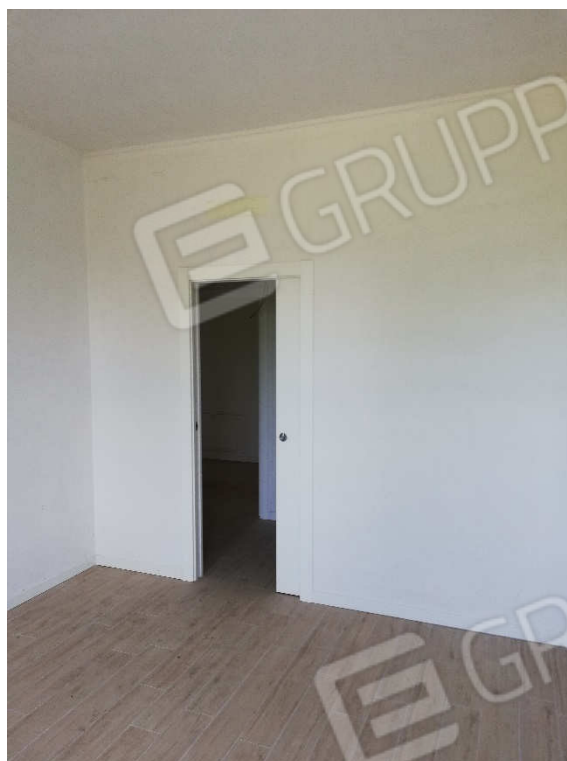
VISTA 42 – appartamento piano T
