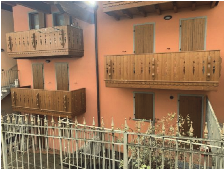
vista esterna da nord
