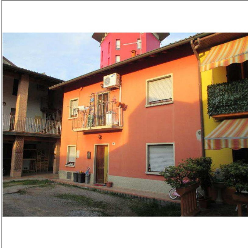
- Casa di civile abitazione - Fronte ovest su corte interna comune -
