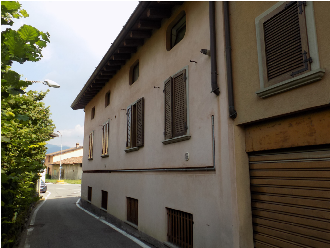
vista fronte nord su via Trussardi Volpi
