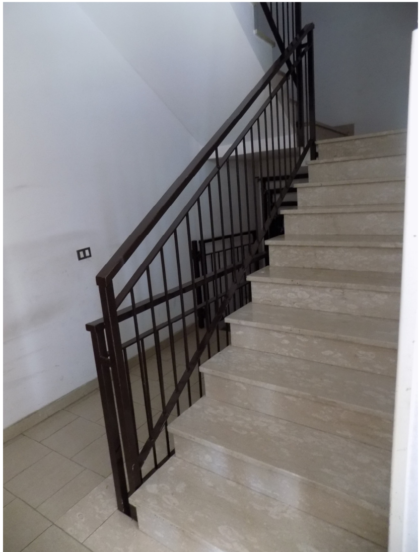
porticato - ingresso / vano scale
