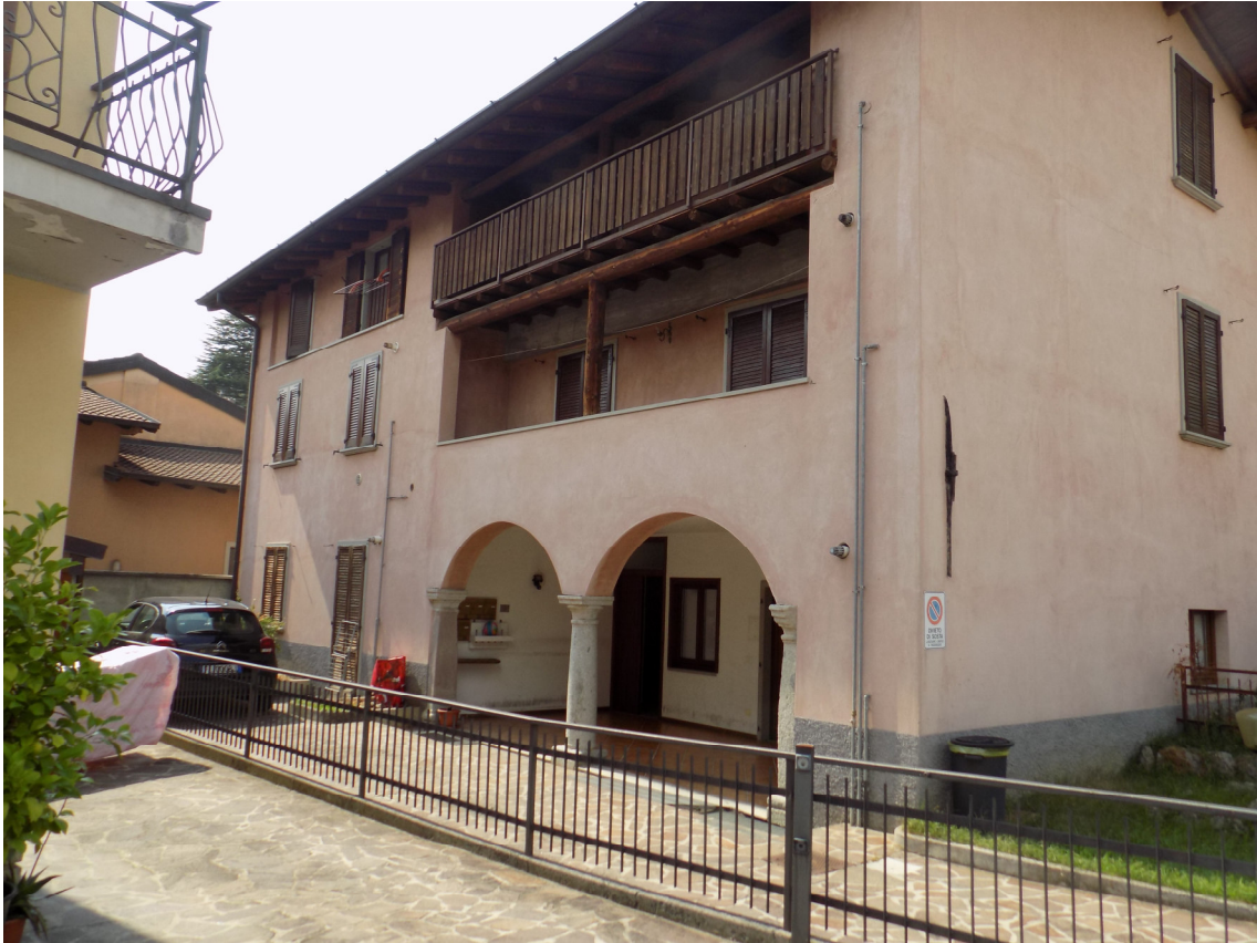
edificio condominiale – vista fronte sud su cortile interno
