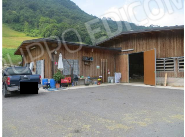
Stalla e locali lavorazione e spaccio
