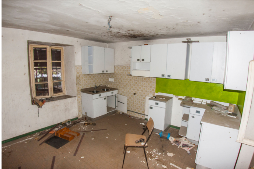
Cucina al piano Terra
