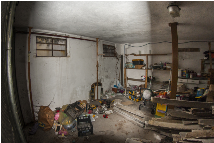
Autorimessa con a destra lastre in fibrocemento tipo Eternit
