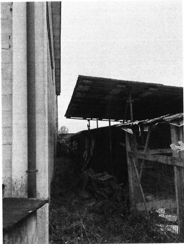
Area esterna lotto – retro baracche e tettoie
