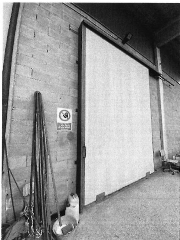
Portellone laterale a est – esterno
