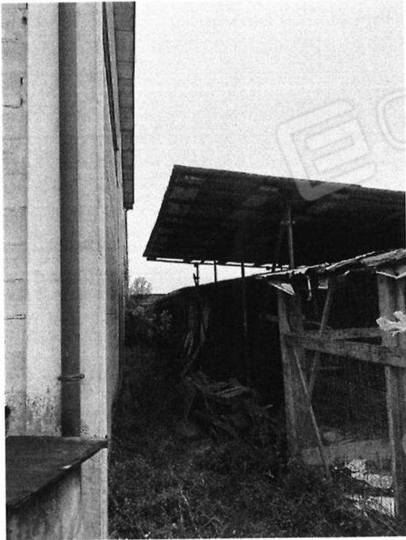
Area esterna lotto – retro baracche e tettoie
