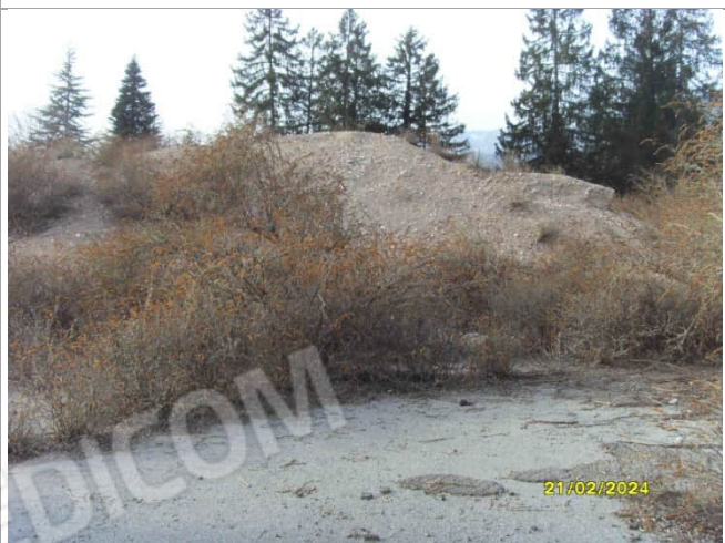
Detriti di cantiere presenti – zona nord ovest
