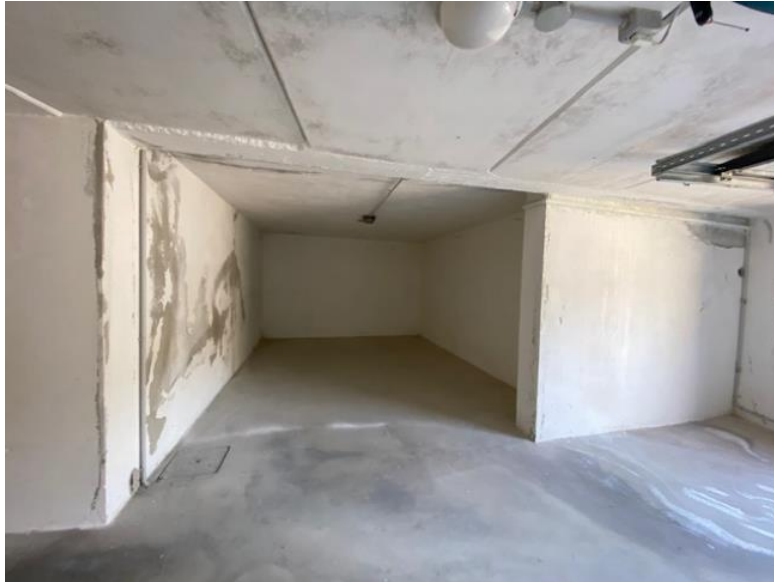
cantina mapp 1558 sub 709 non pignorata accessibile dall'autorimessa
