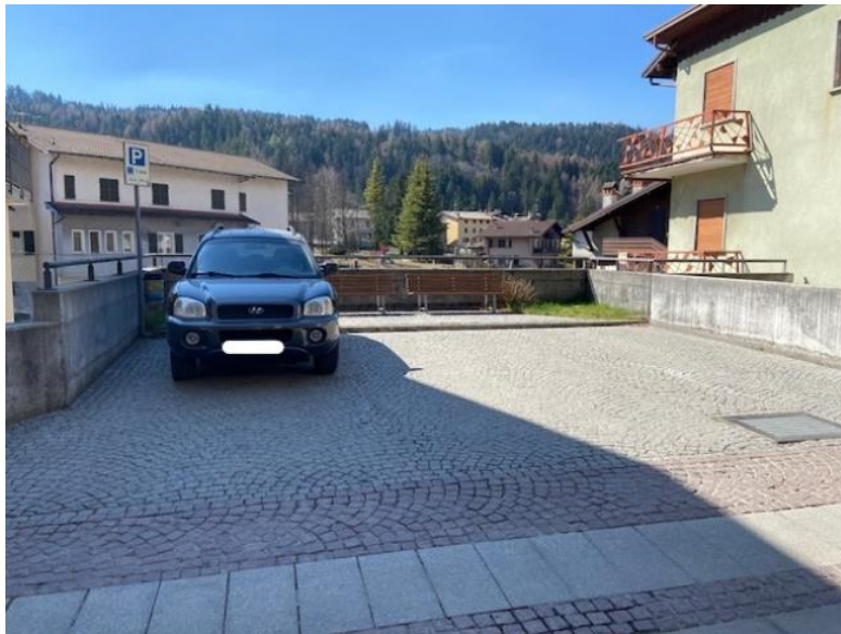
parcheggio pubblico (mapp. 4246 sub 11) che costituisce copertura dell'ufficio
