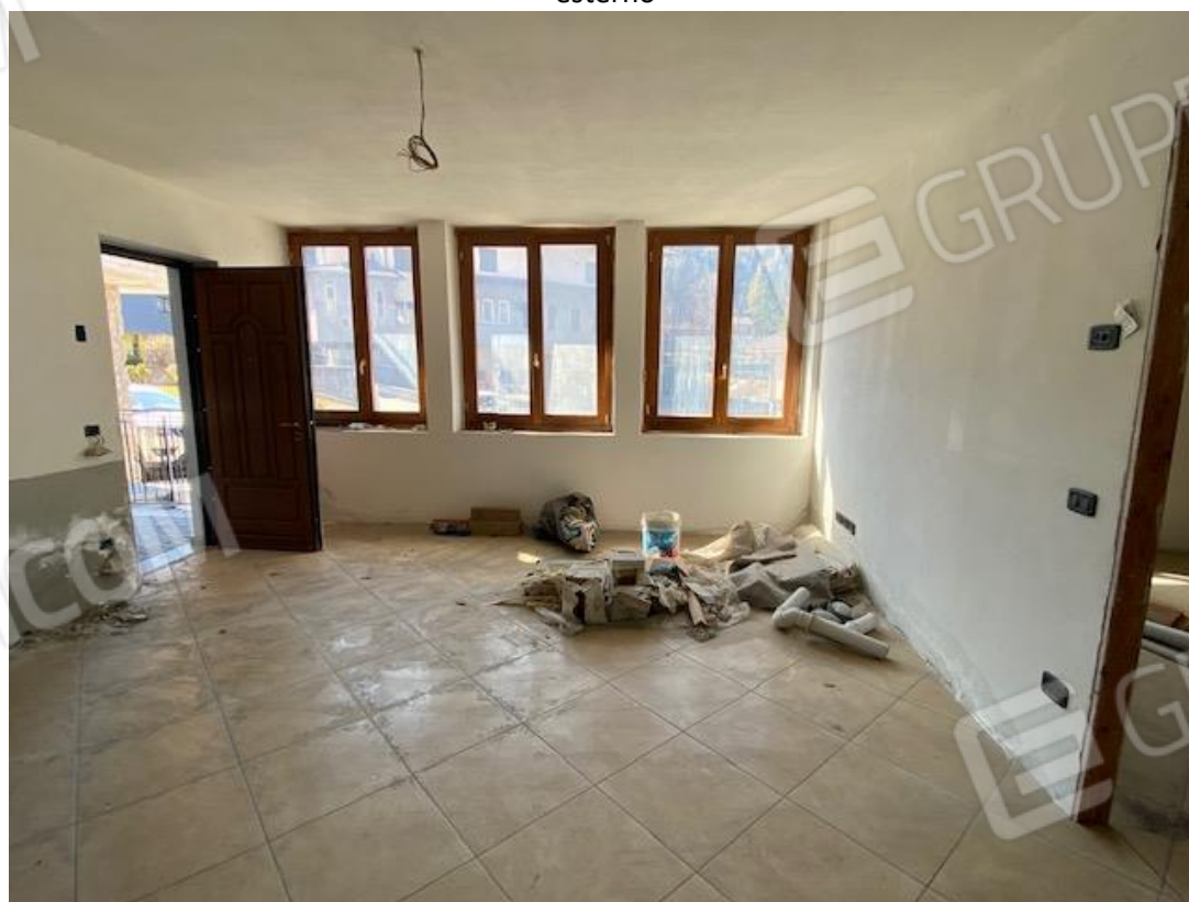
Interno ufficio particella 4246 sub 9
