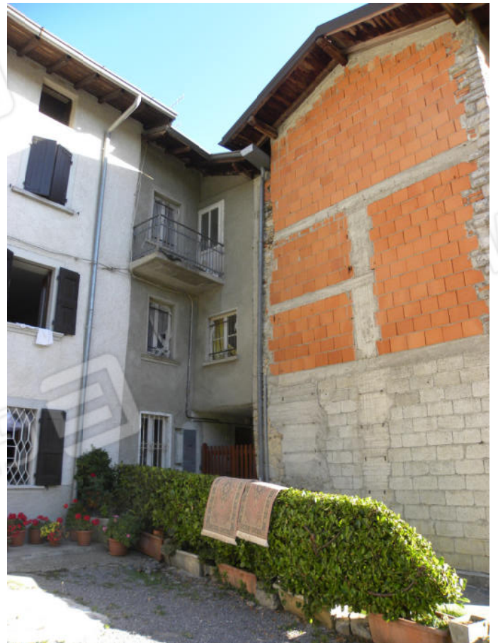
ESTERNO ANGOLO SUD EST - INGRESSO
