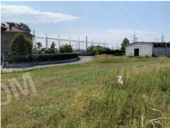
Foto 7 – strada di lottizzazione da completare
