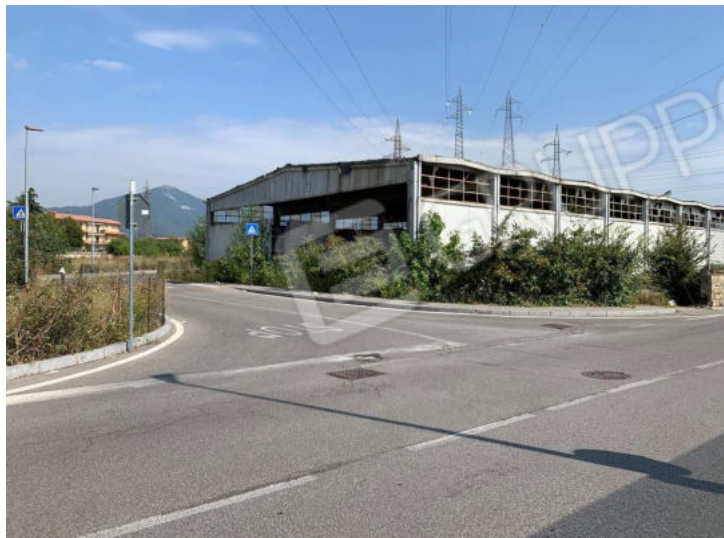
Foto 12 – capannone - comparto E
