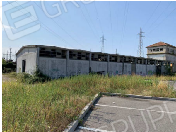
Foto 8 – capannone comparto E
