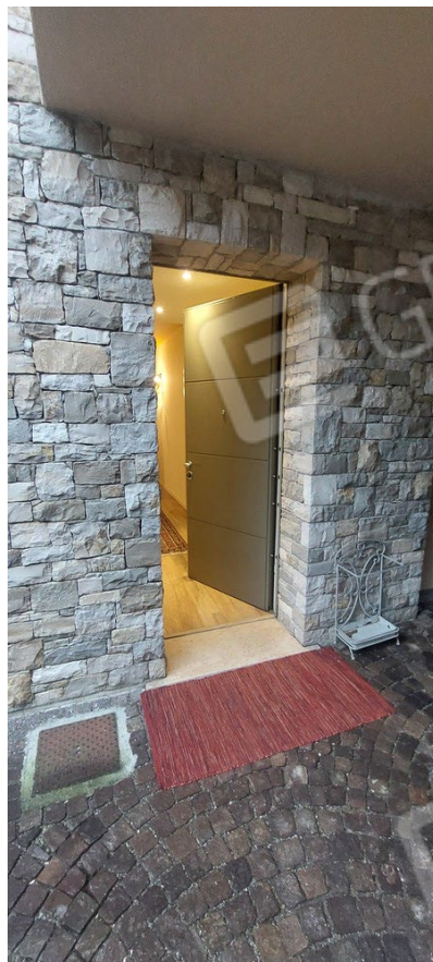
ENTRATA DA ESTERNO AL PIANO INTERRATO
