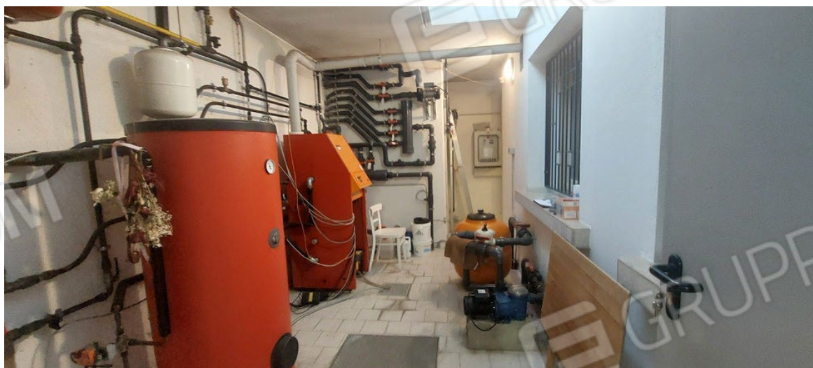
PIANO INTERRATO INTERCAPEDINE COPERTA – ZONA CENTRALE TERMICA E IMPIANTI PISCINA
