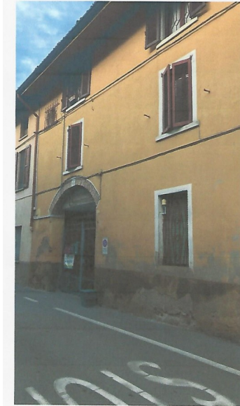
Fronte via F.Mazza
