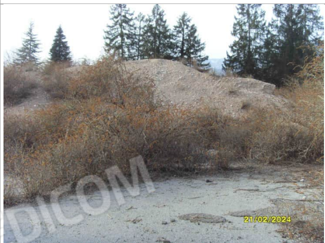
Detriti di cantiere presenti – zona nord ovest
