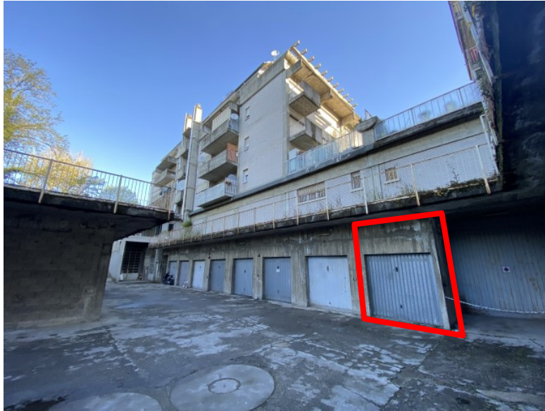
Vista autorimessa piano interrato
