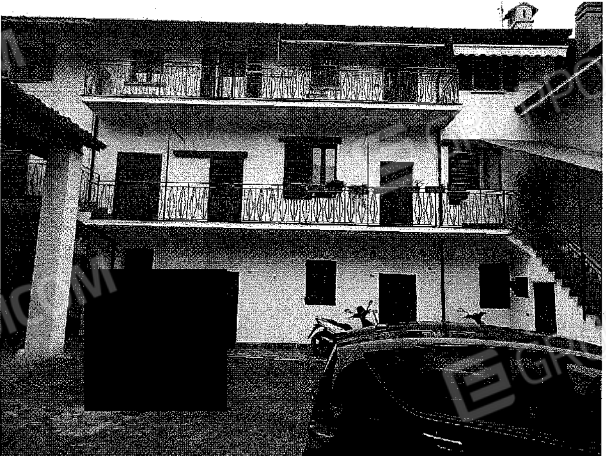
VISTA DEL FRONTE DEL FABBRICATO DAL CORTILE
