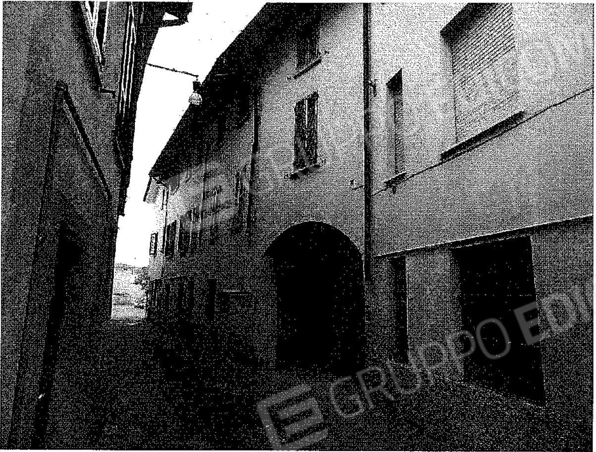
FRONTE STRADA VICOLO SCURI
