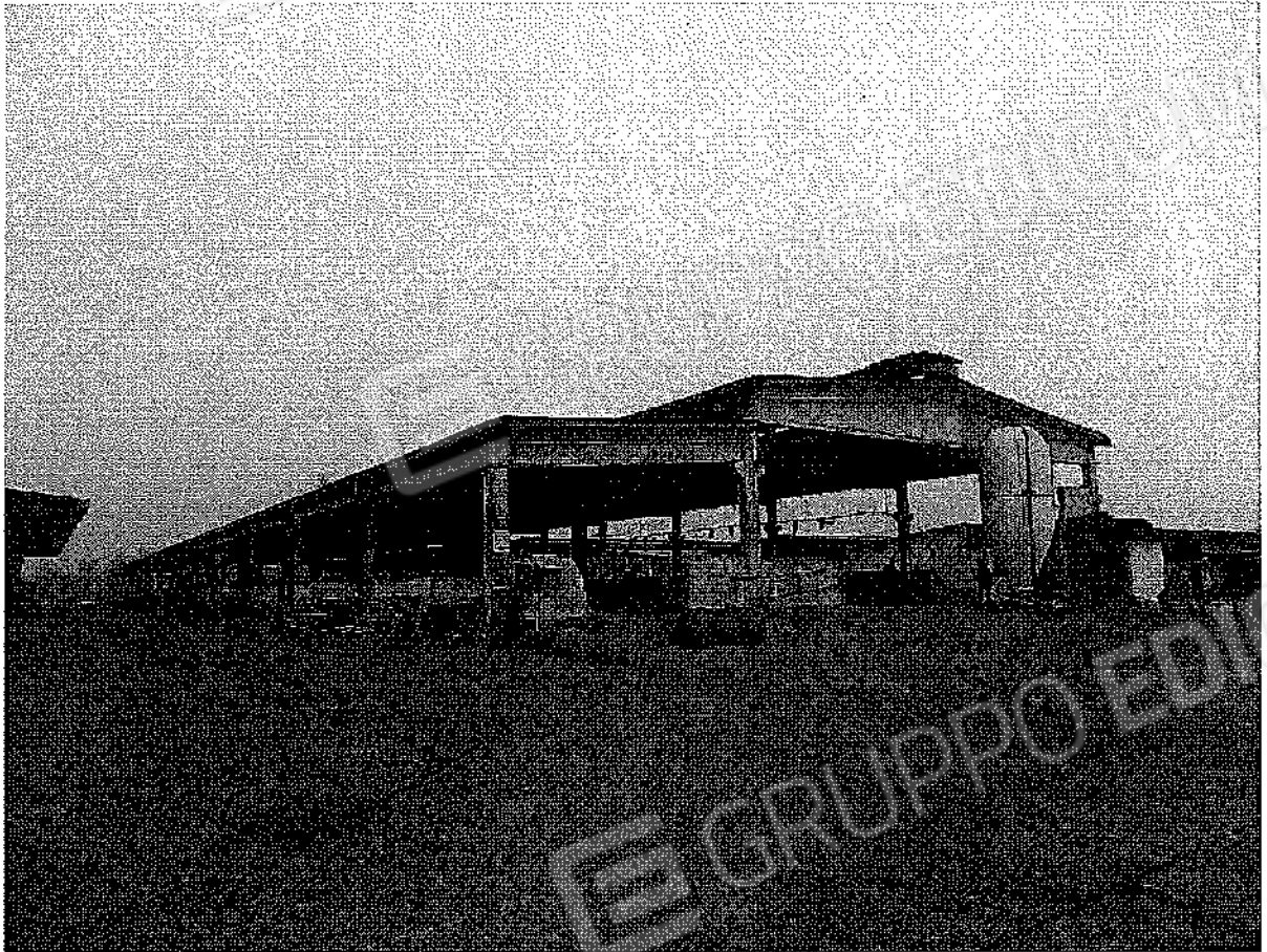
VISTA DA SUD-OVEST DELLA STALLA IN C.A.
