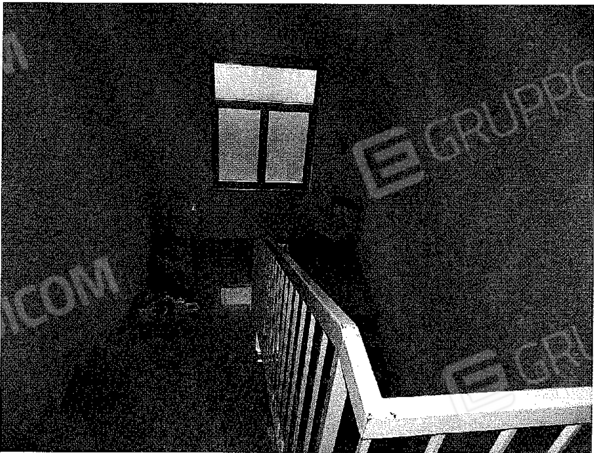
SCALA DI ACCESSO AL SOLAIO
