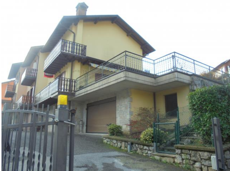
vista da ingresso carrale piano interrato (da nord)
