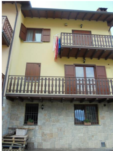
particolare fronte est alloggio
