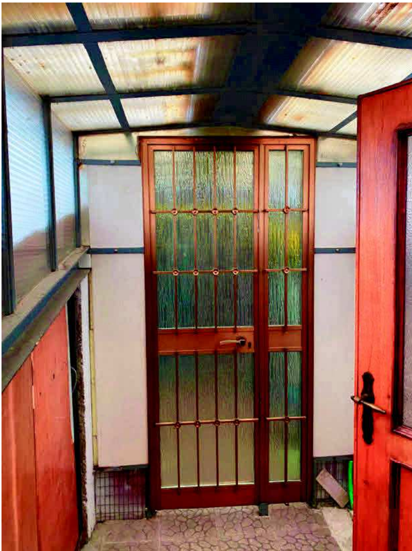
vano scala ed ingresso sottotetto
