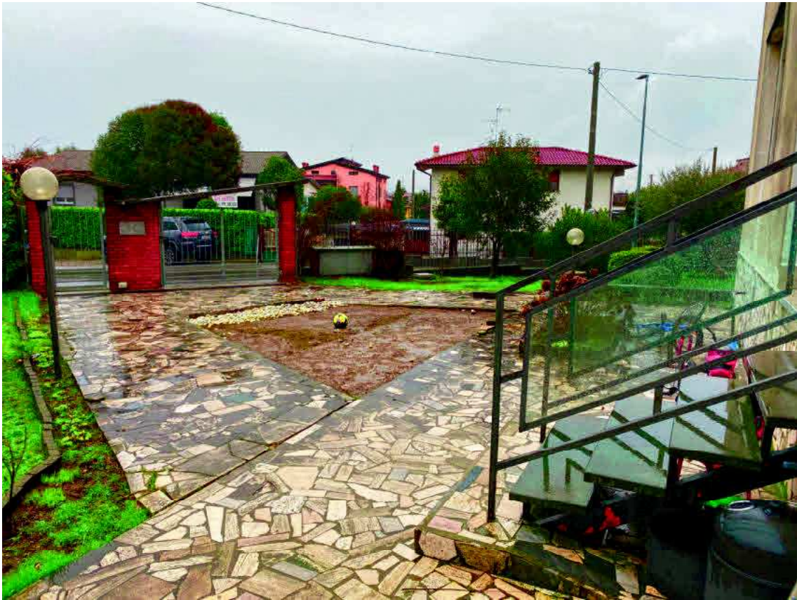
zona ingresso a nord
