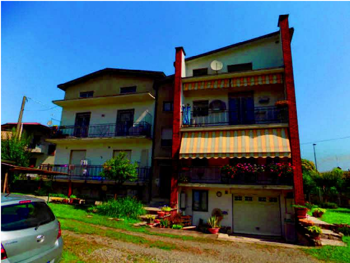
fronte sud unità primo / secondo piano a destra
