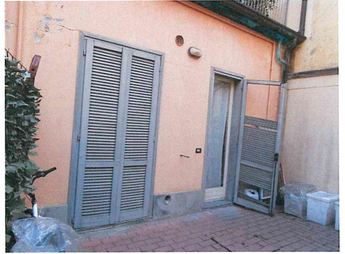
Foto 08 - Prospetto Sud alloggio
