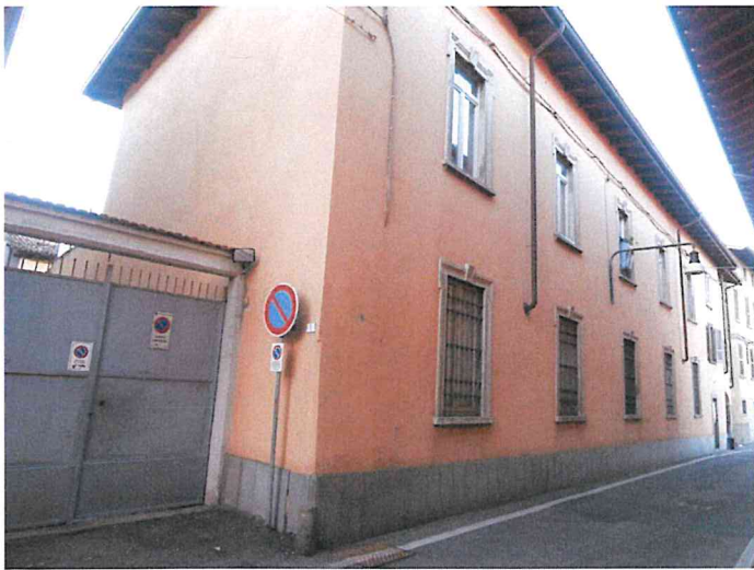
Foto 03 - Prospetti Nord ed Est edificio
