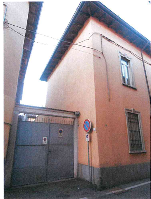
Foto 06 - Prospetti Nord ed Est alloggio
