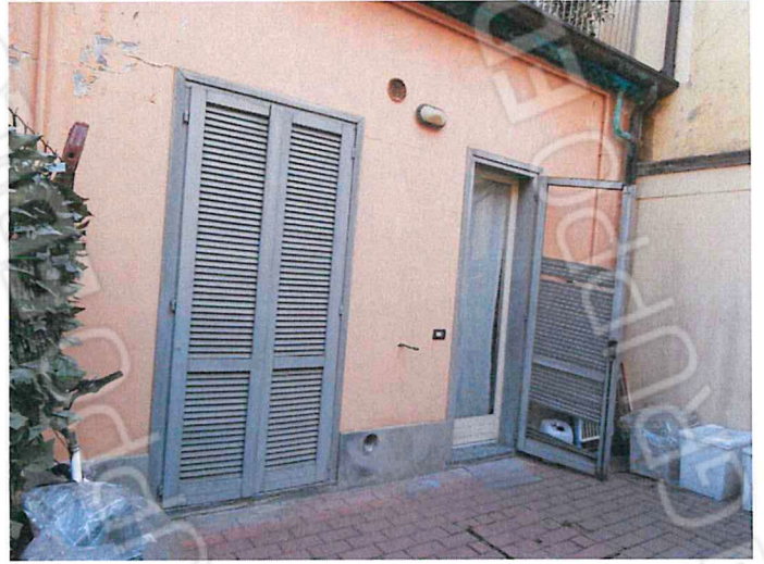
Foto 08 - Prospetto Sud alloggio
