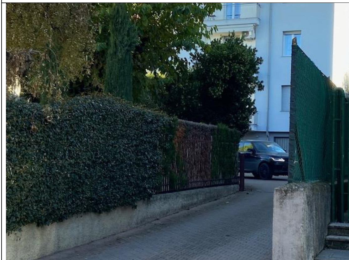
Foto 4 Accesso accrabbie e pedonale da via Daminelli
