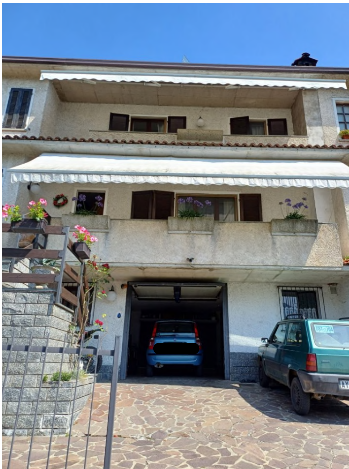
Vista esterna autorimessa al piano seminterrato
