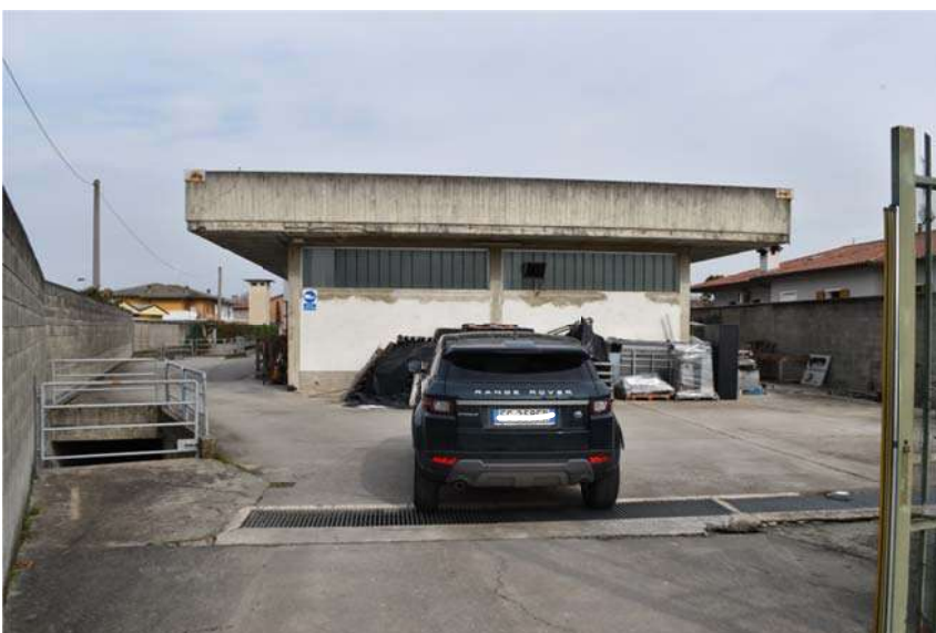
Foto n. 2 Vista del fabbricato dalla via don Buroni
