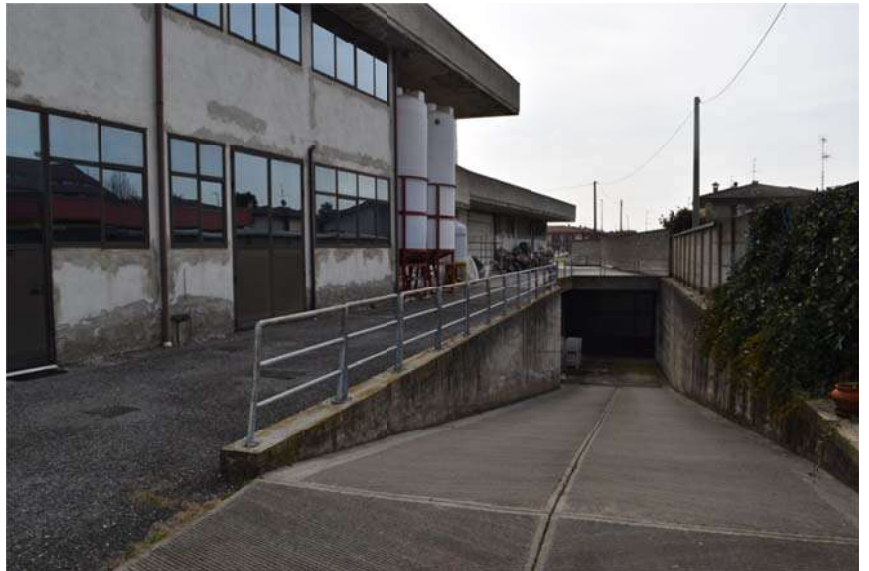
Foto n. 4 La rampa d'accesso al piano interrato sul lato Ovest
