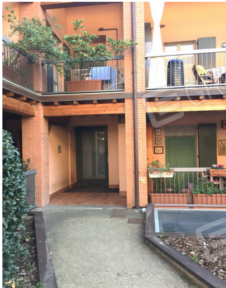
Ingresso dal cortile
