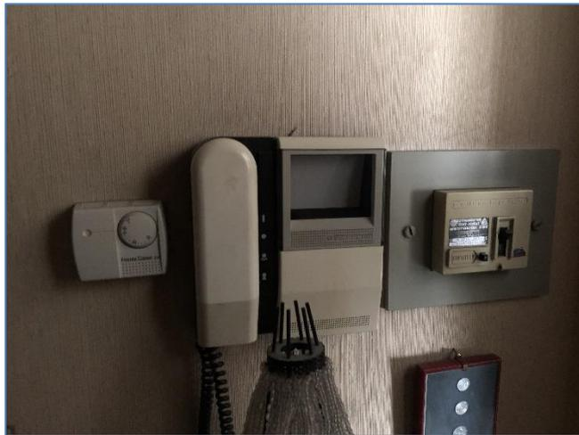
**Foto 30: quadro elettrico, impianto videocitofono e cronotermistato**
