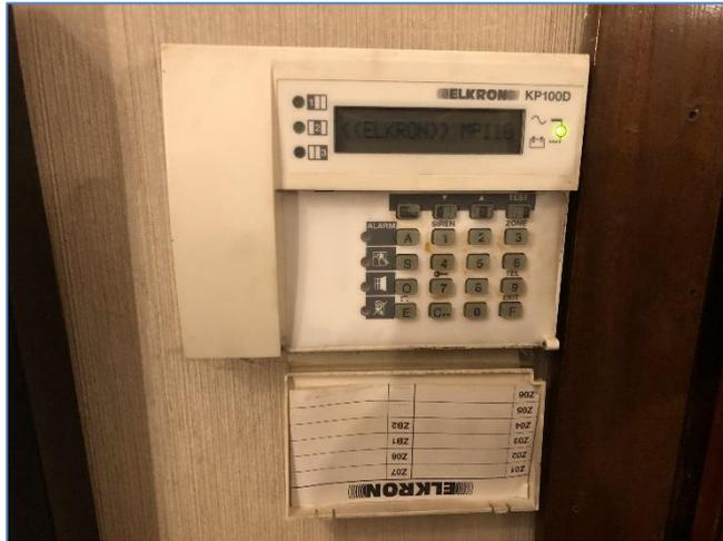
**Foto 29: centralina sistema d'allarme**
