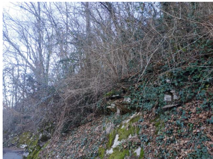
Corpo A1 area boschiva posta a monte della ciclopedonabile
