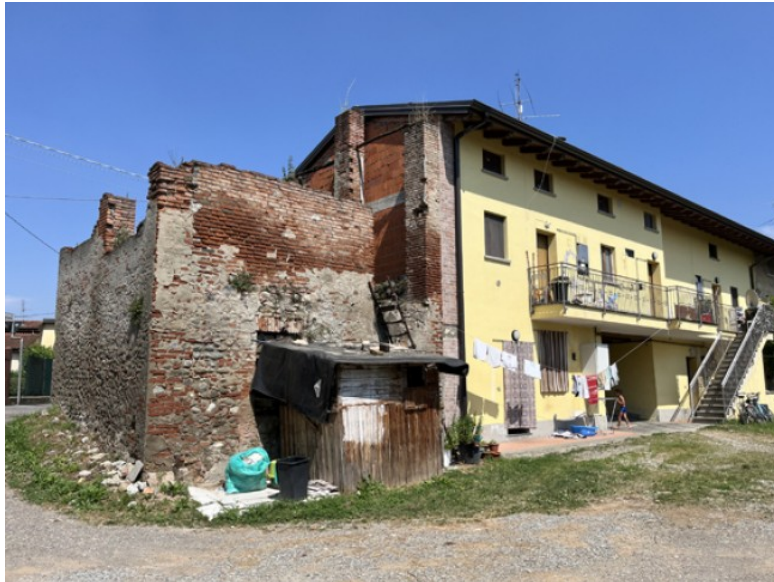
Fronte su cortile cond.le
