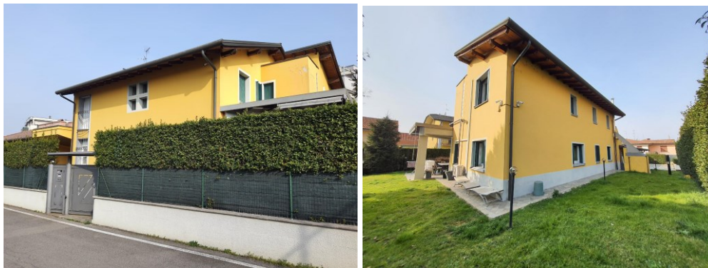
Abitazione in Villino - Sub. 701 + Spazi esterni Cortile e Giardino - Sub. 1
