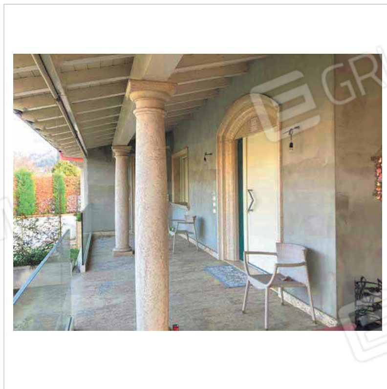
L'ingresso al piano terra
