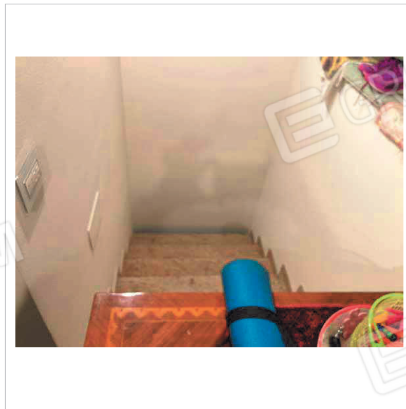
Una delle scale che collegheranno gli ambienti in corso di costruzione
