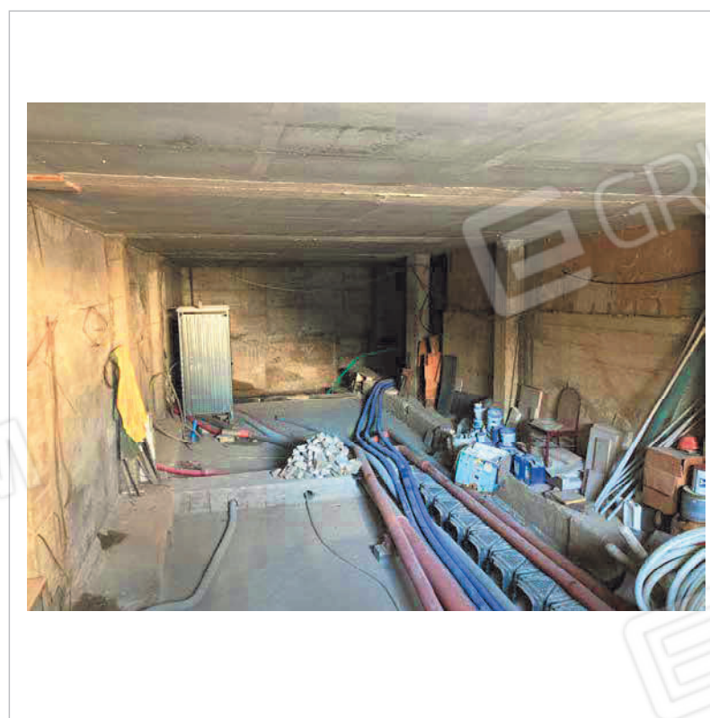
L'unità in corso di costruzione
