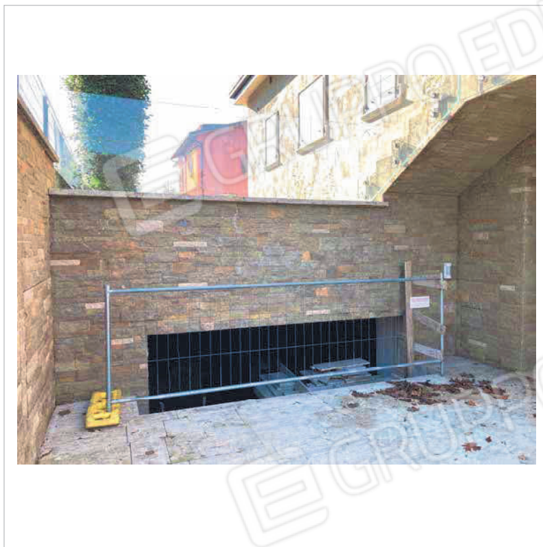
Bucatura sull'unità in corso di costruzione
