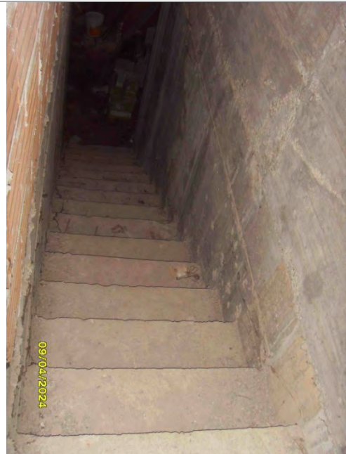
Scala di accesso al piano Interrato
