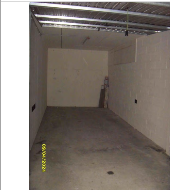
Autorimessa – p.lla 8760 sub 37
