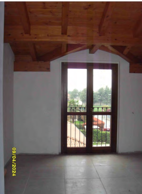
Sottotetto da recuperare in corso di costruzione
