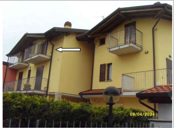
Sottotetto P. 2° - p.lla 8760 sub 18
