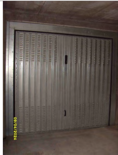
Autorimessa – p.lla 8760 sub 37
