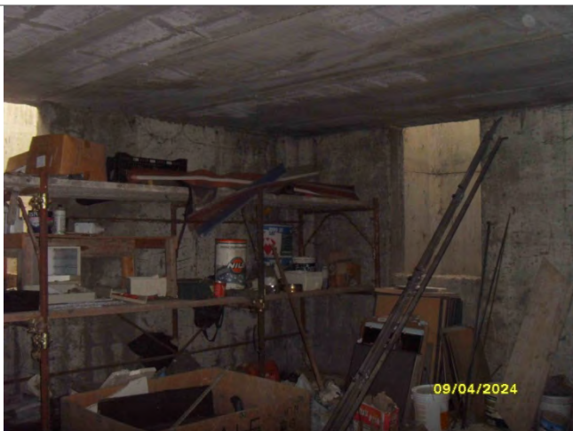
Piano Interrato in corso di costruzione
