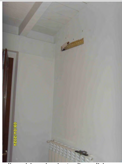
Predisposizione impianto di condizionamento
