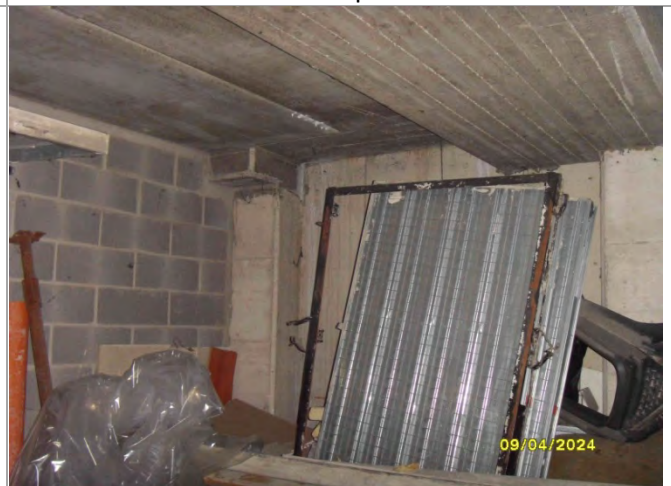
Piano Interrato in corso di costruzione
