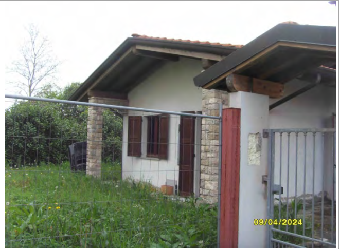
Villetta di testa in corso di costruzione
