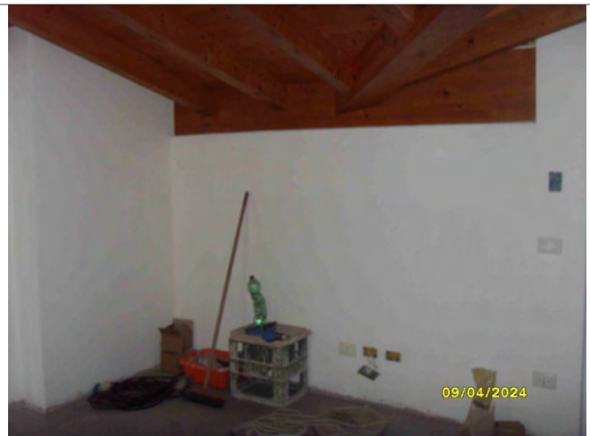
Sottotetto da recuperare in corso di costruzione
