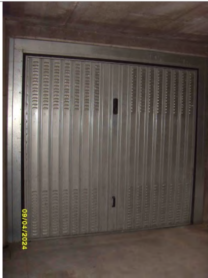
Autorimessa – p.lla 8760 sub 28
