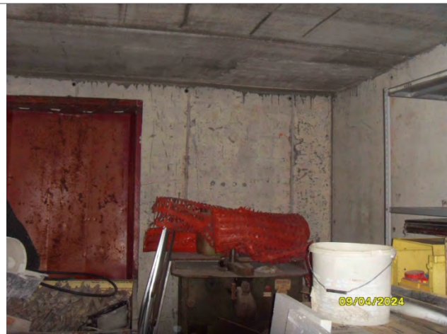
Autorimessa in corso di costruzione
