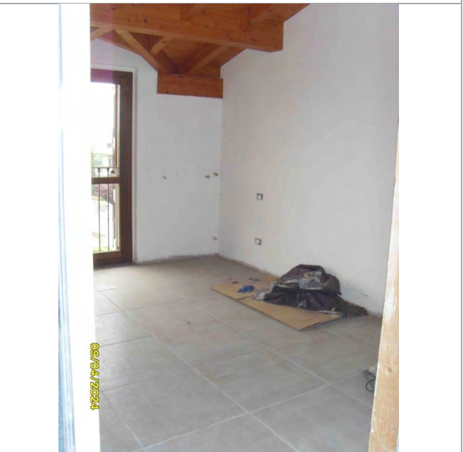
Sottotetto da recuperare in corso di costruzione
