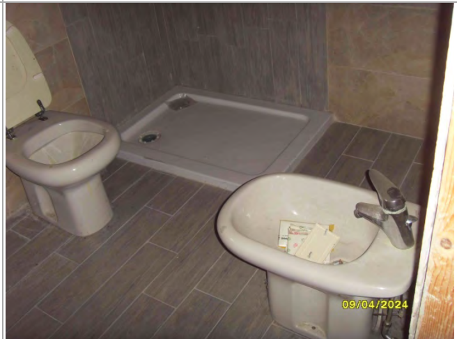
Sottotetto da recuperare in corso di costruzione
