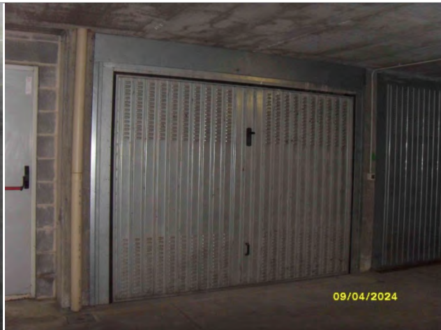
Autorimessa in corso di costruzione
