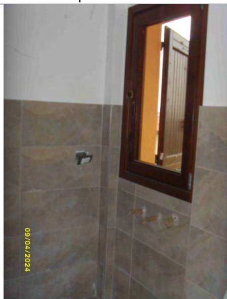
Sottotetto da recuperare in corso di costruzione
