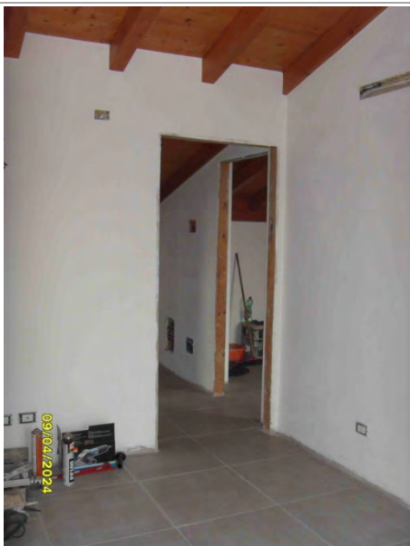
Sottotetto da recuperare in corso di costruzione
