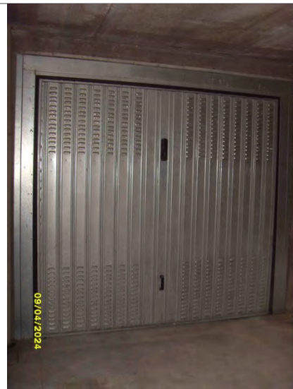
Autorimessa – p.lla 8760 sub 36
