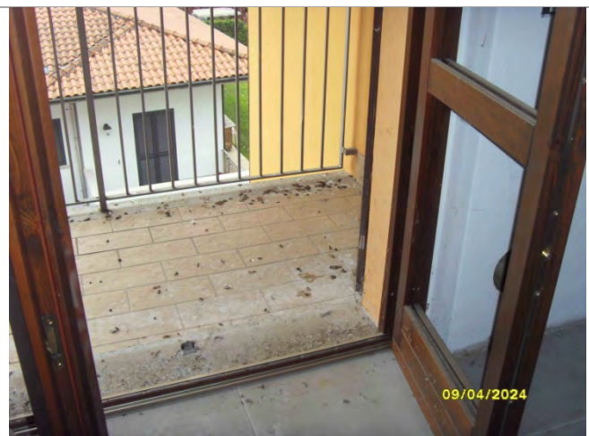
Sottotetto da recuperare in corso di costruzione
