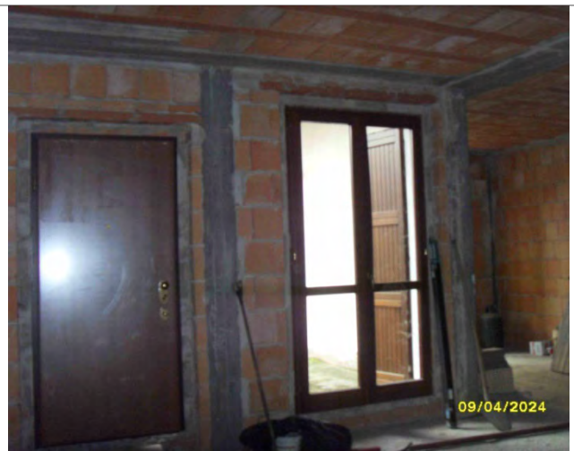
Interno Piano Terra
