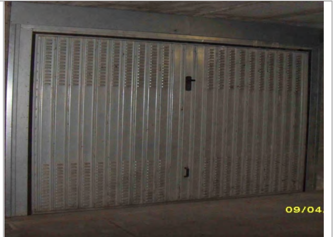
Piano Interrato in corso di costruzione
