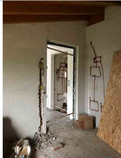
Ingresso sottotetto p.lla 8760 sub 19
