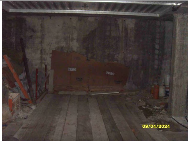
Piano Interrato in corso di costruzione
