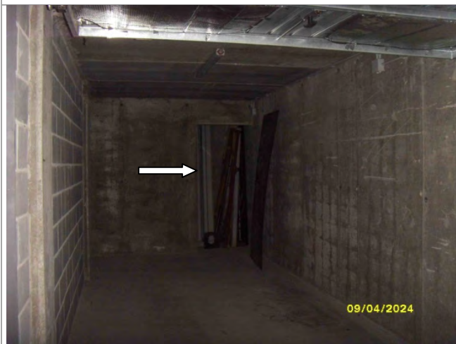
Autorimessa – p.lla 8760 sub 740 e cavedio
