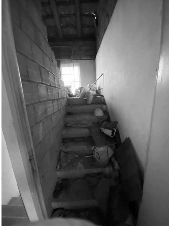
Scala accesso sottotetto (Cespite 2)
