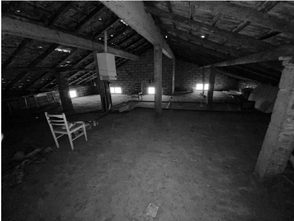
Piano Sottotetto (Cespite 2)
