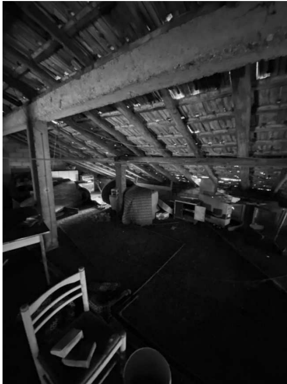
Piano Sottotetto (Cespite 2)
