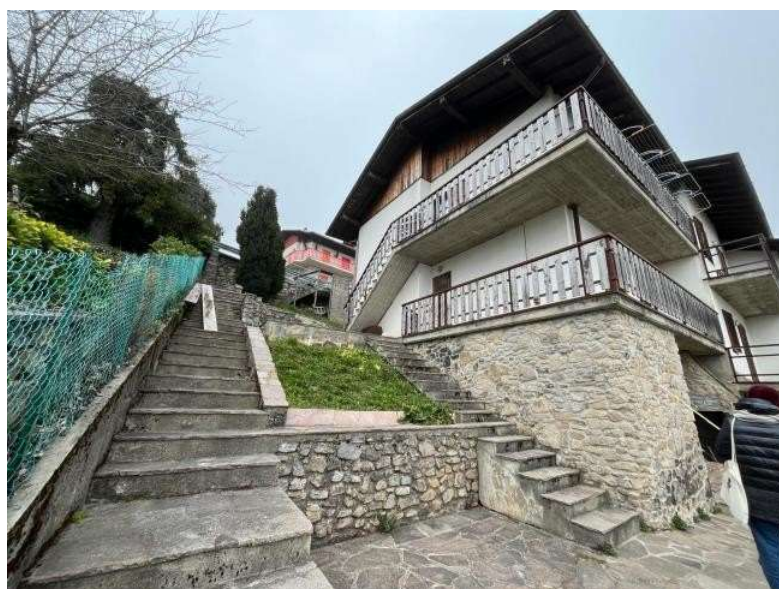
Fronte Sud- Ovest - P. sem. P. rial e P. 1
